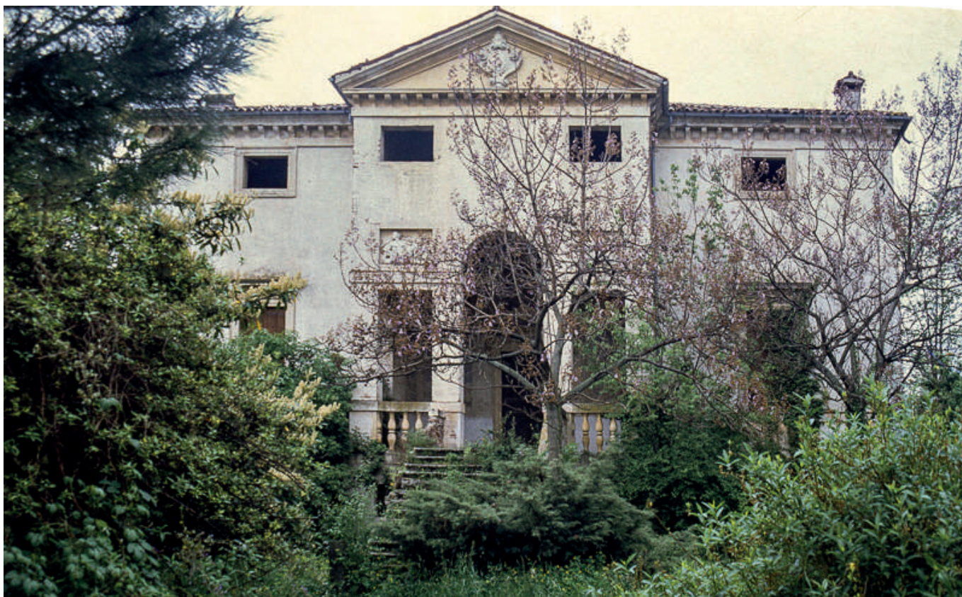
Fig. 13. Villa Forni Cerato, Immagine fotografica della facciata principale nel 1992 (foto Jacqueline Poggi)
