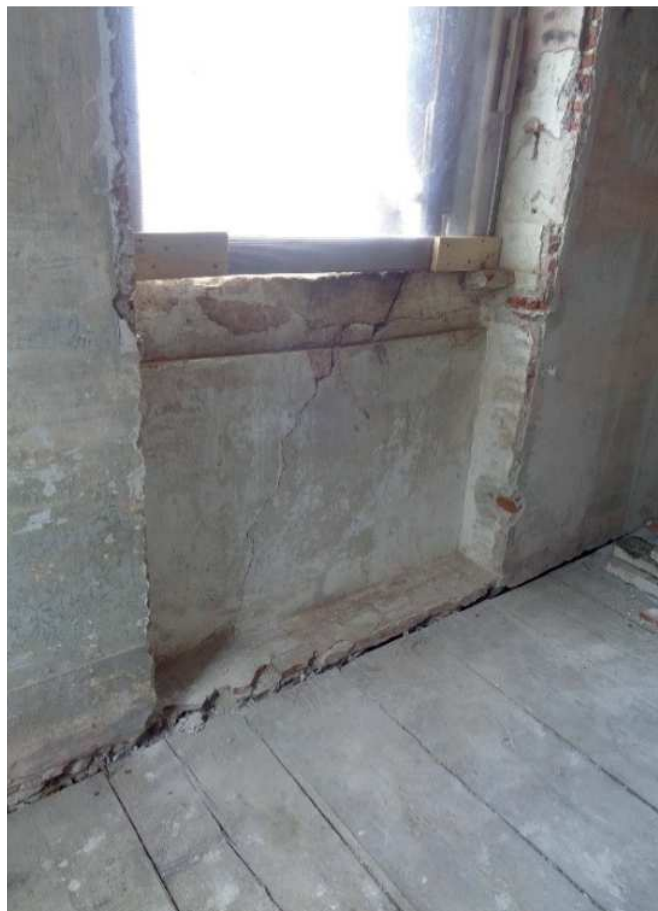
Le nicchie sottofinestra ripristinate (1)
