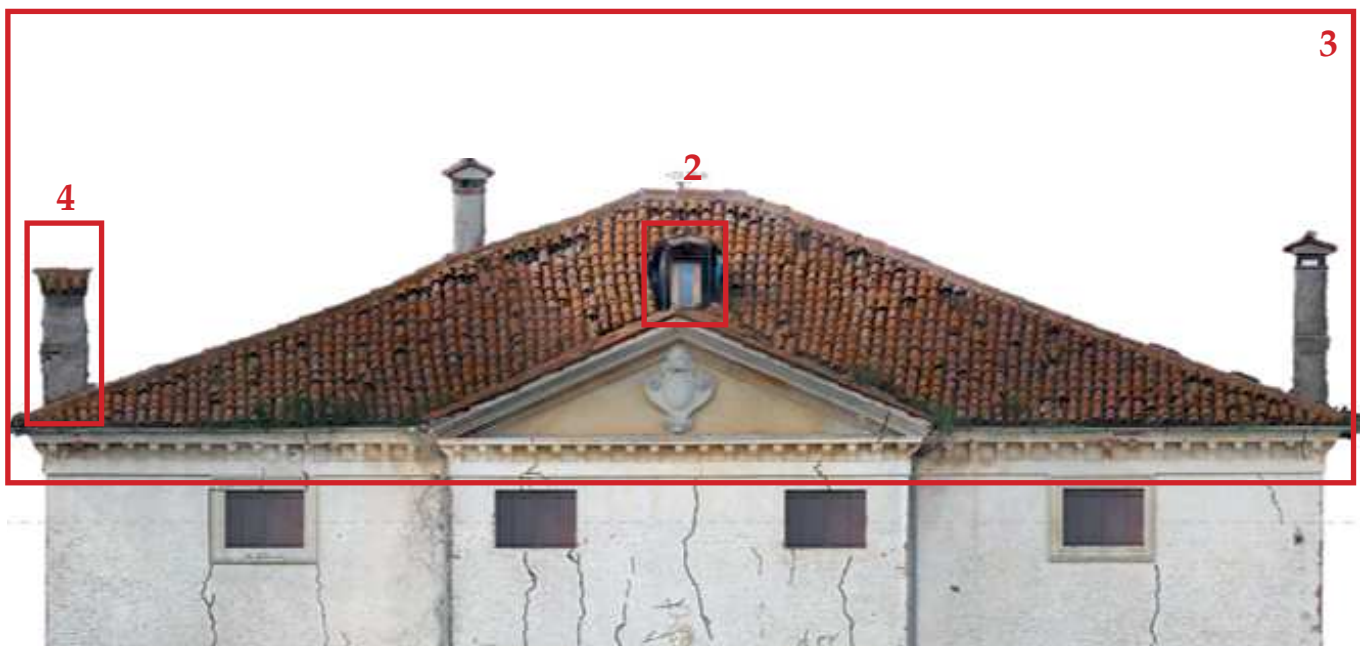
Particolari del tetto a confronto tra il 1778 e lo stato di fatto
