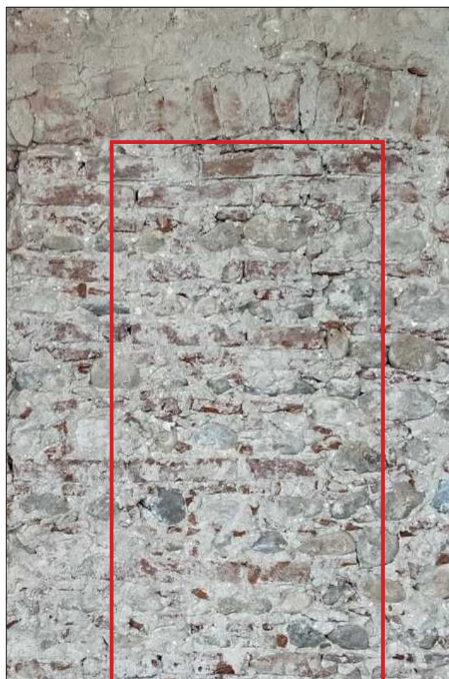
La porta tamponata della parete 2 a nord
