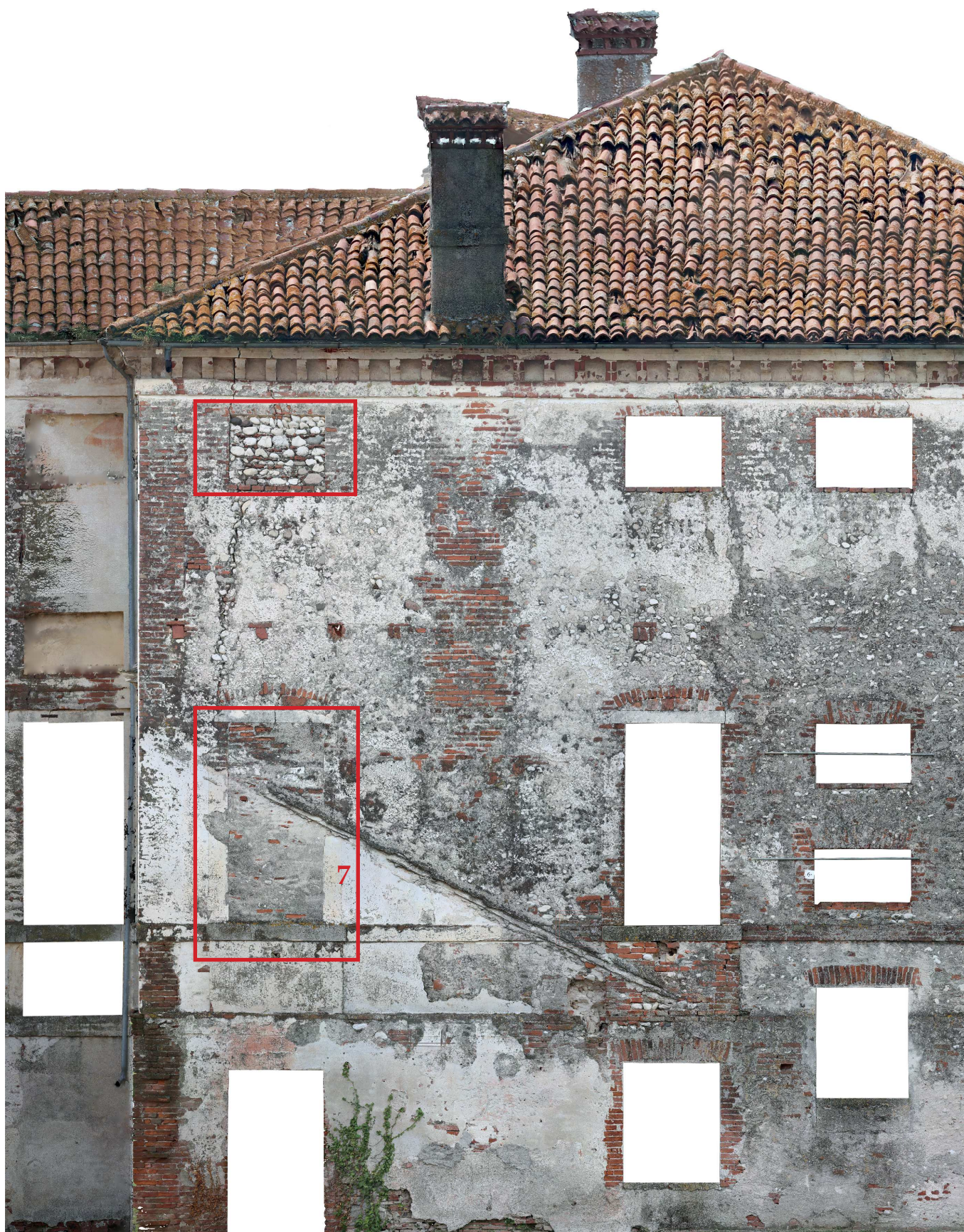
I tamponamenti di due finestre sulla facciata est nello stato di fatto nel 2018
