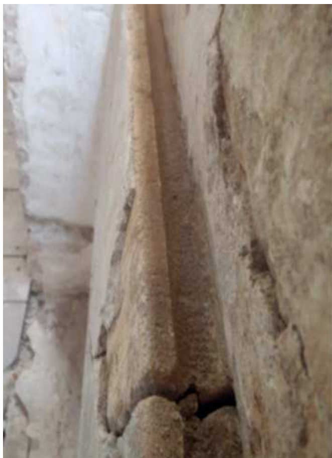
I gocciolatoi per il drenaggio dell'acqua (2) e i lacerti dei pavimenti originali (3)
