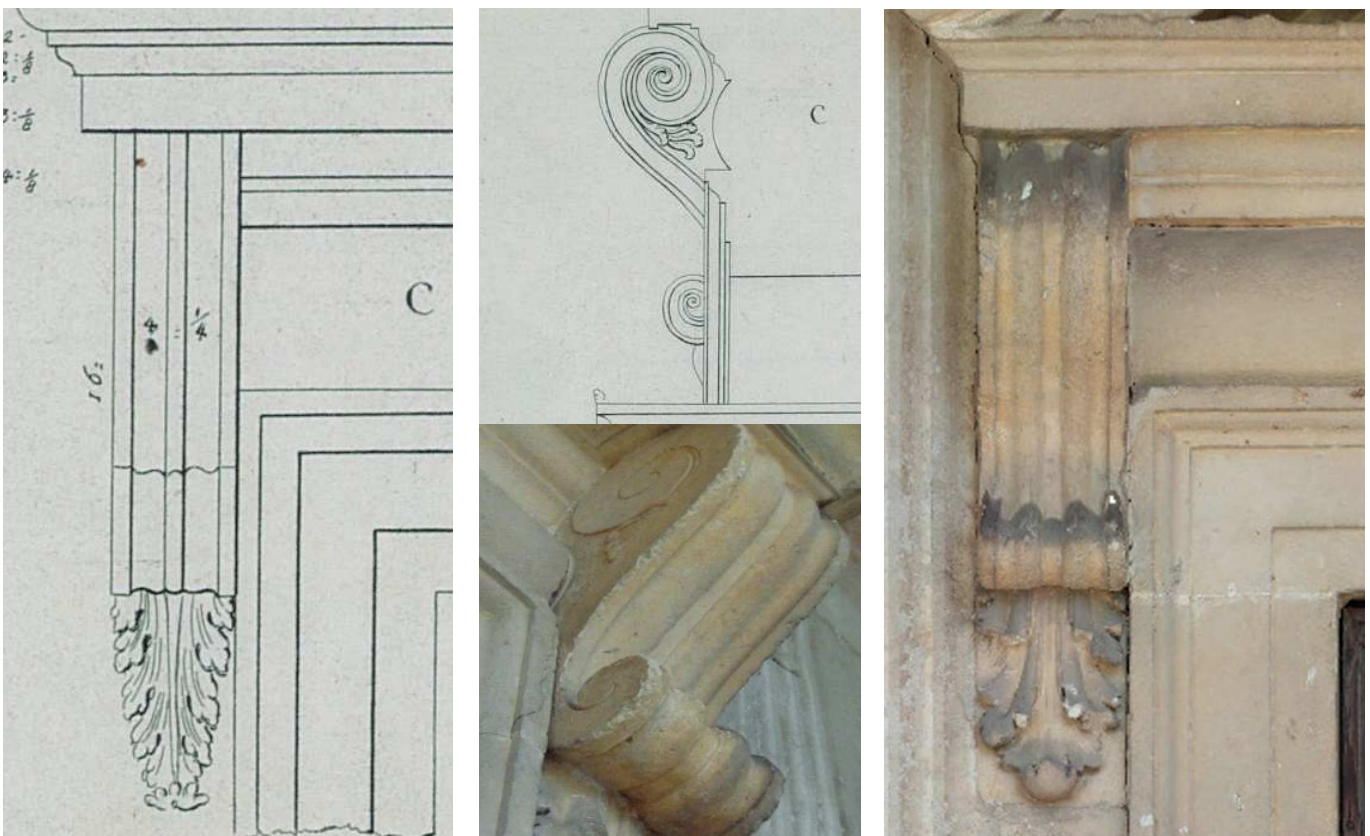
Confronto fra il dettaglio C delle modanature nel rilievo del 1778 e nello stato di fatto
