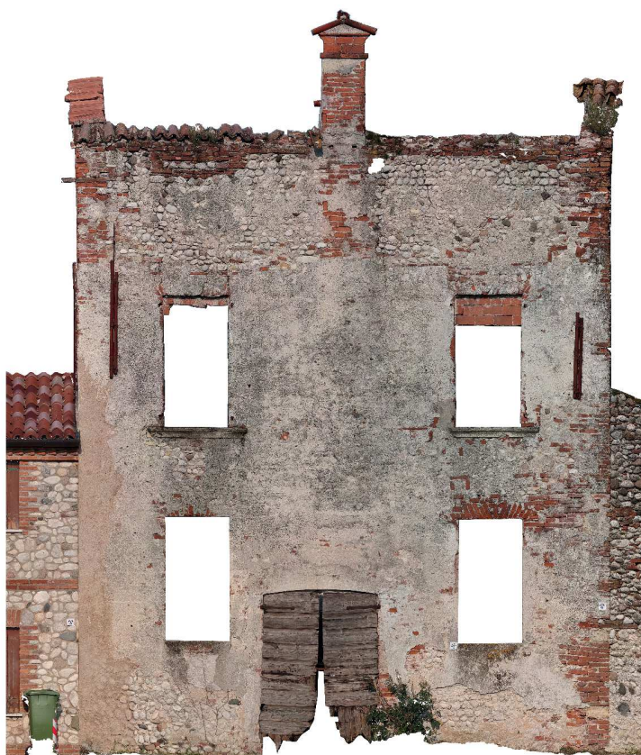
Prospetto est del rudere
