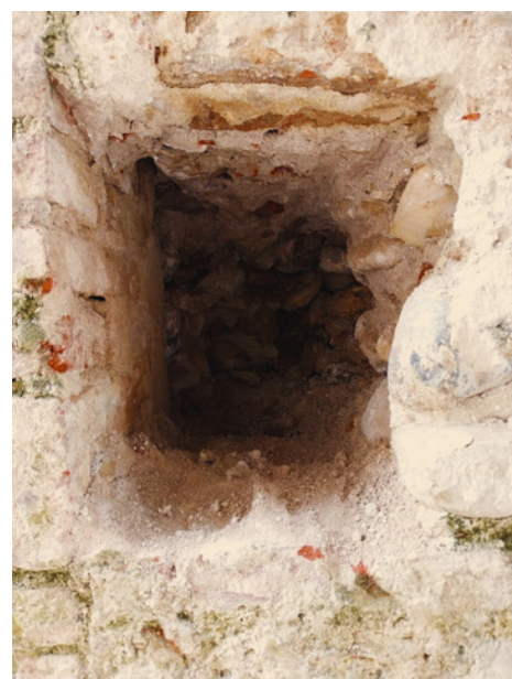
Saggio sotto la scalinata da nord, che mostra la spalletta muraria di un ingresso
