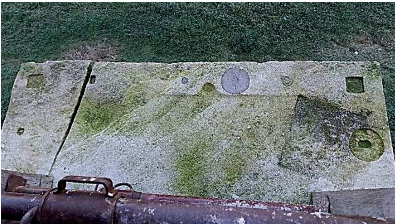
Il terrazzo sul lato nord costruito nel 1902
