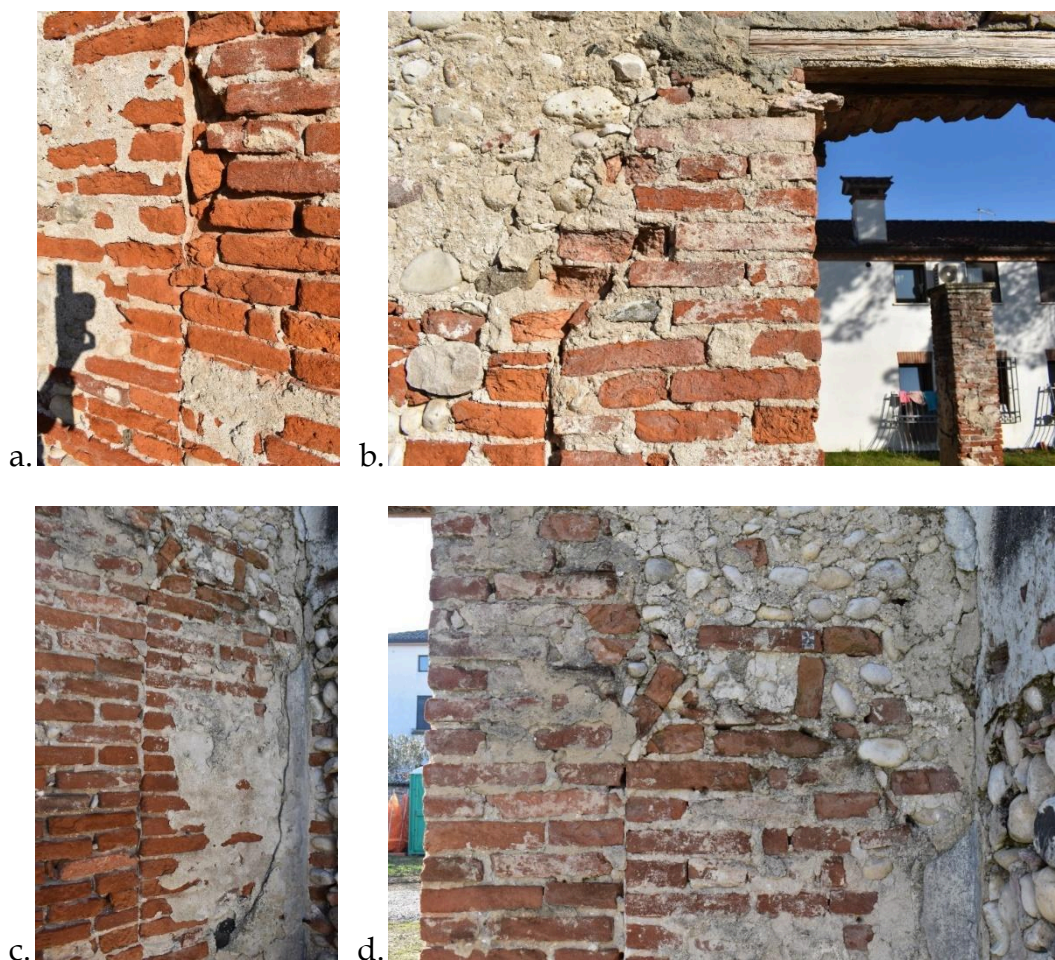
Figura 38. Dettagli dell'apertura a sud-ovest sul prospetto occidentale: a) spalletta nord precedente a quella attuale con lacerti di intonaco e spalletta successiva in appoggio; b) imposta dell'arco a partire da una tavella; controfacciata: c) spalletta nord con lacerti di intonaco; d) imposta dell'arco con il primo mattone della piattabanda.
