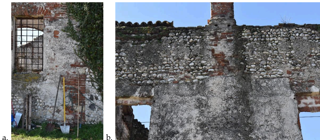
Figura 33. Dettagli della parete orientale della torre colombara est: a) Cantonale N-E, a cui si appoggia il muro che delimitava la tettoia nord; b) Sopraelevazione della torre.
