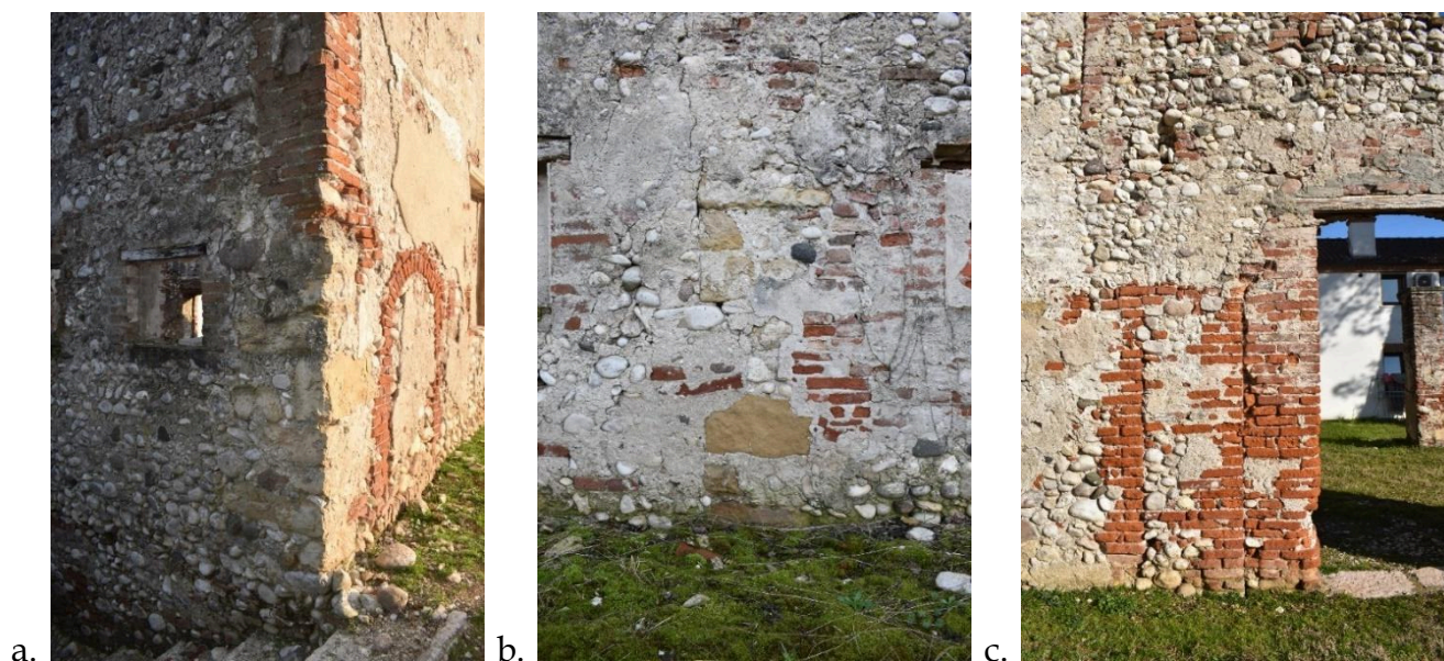
Figura 30. Angolate della casa del padre: a) spigolo nord-ovest; b) dettaglio del cantonale tra la casa, a destra, e la torre colombara, a sinistra; c) spigolo sud-ovest che delimita la "navata" della casa (si tratta del filare in mattoni verso sinistra).
