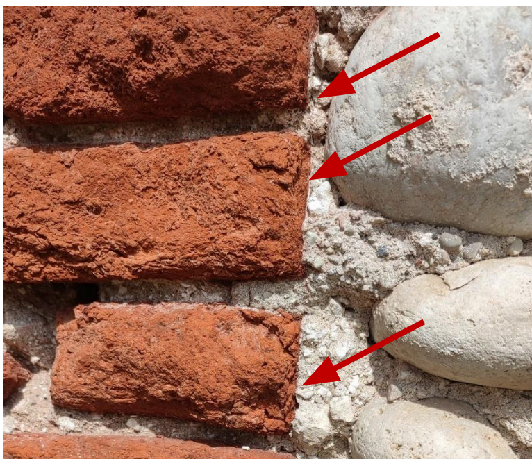
Figura 31. Dettaglio del sottile strato di scialbatura che copriva il cantonale finito in mattoni pieni all'angolo S-O della casa, con ciottoli e malta sulla prosecuzione del muro che vi si appoggiano.
