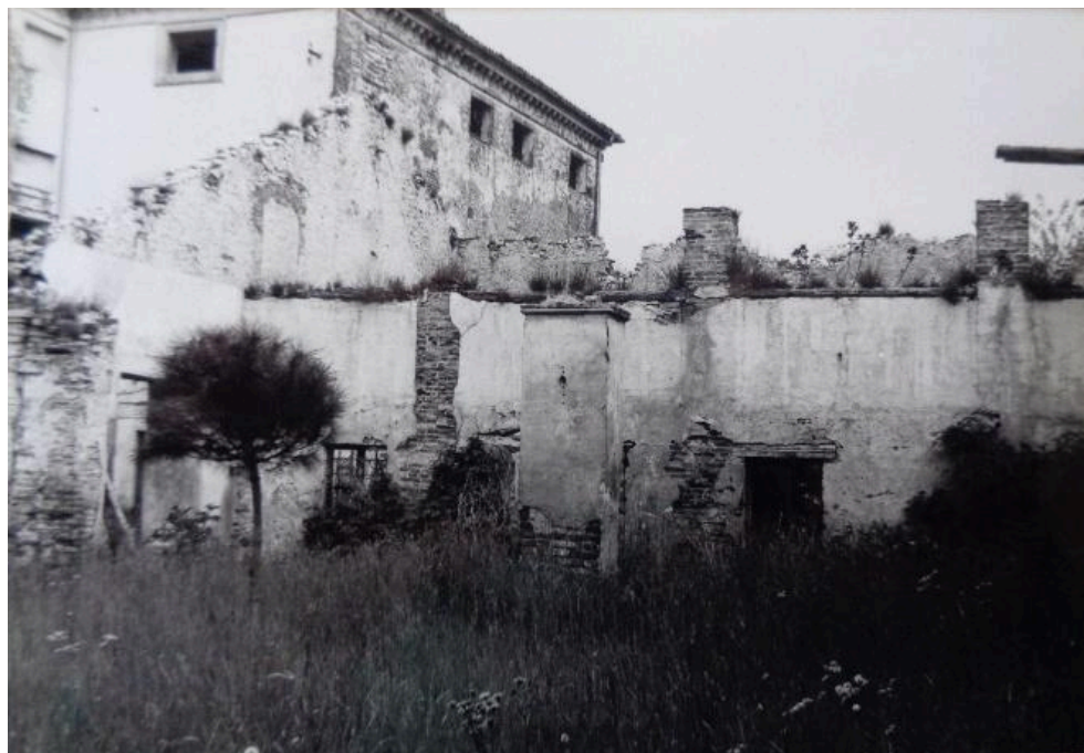
Figura 25. Vista del prospetto sud del rustico; Foto scattate dal Geom. R. Tescari nel 1978. (Archivio Patrimonio SABAP-Vr).
