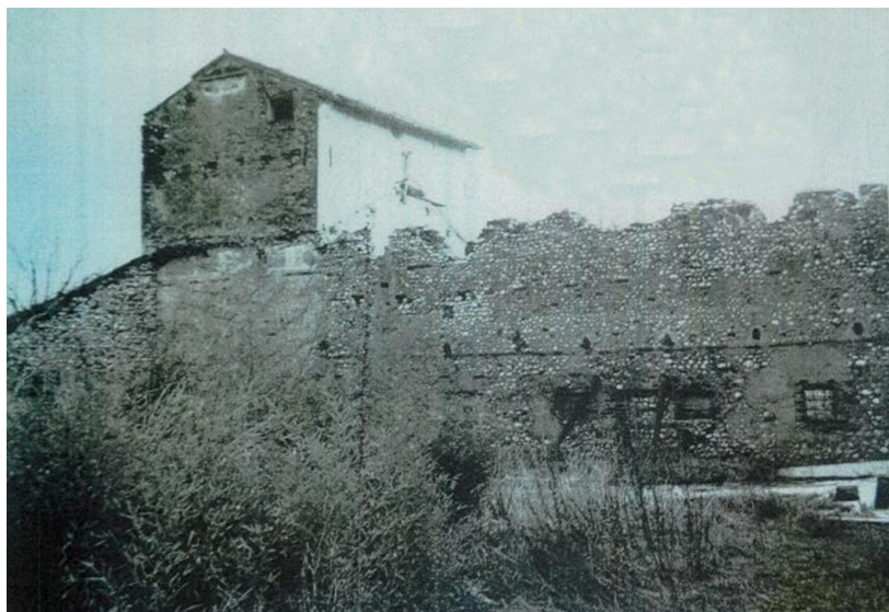
Figura 22. Vista da nord del corpo est nel 1978. Si nota che la copertura della torre è ancora in sede (crollerà tra il 1978 e il 1980), mentre quella del corpo allungato è già crollata. (Archivio Patrimonio SABAP-Vr)
