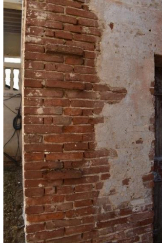
Figura 43. a) Tracce del setto che collegava la villa alla casa del padre con le morse d'attesa visibili sull'angolo della villa, verso il basso, e a poco più di metà altezza sulla casa del padre; b) dettaglio dell'alloggio di un mattone inclinato sul cantonale N-O della casa; c) dettaglio dello spigolo S-E della villa, con rottura dell'intonaco e cantonale in mattoni pieni con morse d'attesa in fase con il cantonale stesso.
