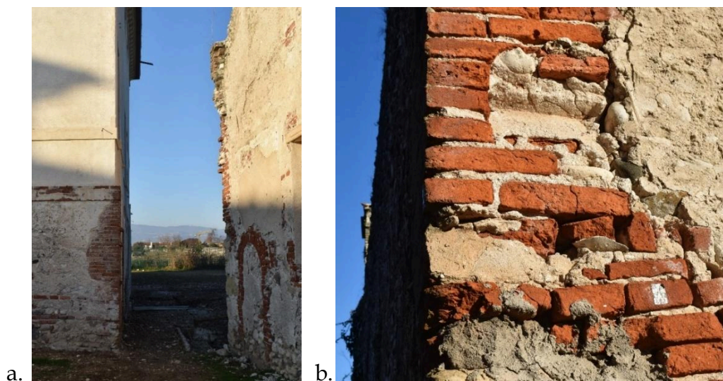
Figura 42. Parte ipogea del muro settentrionale della casa: a) giunti di malta con terra all'interfaccia tra il perimetrale nord della casa e la sua parte ipogea; b) dettaglio dell'appoggio del muro occidentale della cantina a quello settentrionale della casa.
