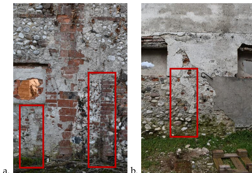
Figura 39. Spallette di una possibile porta sulla parete settentrionale della casa: a) lato esterno, sul quale si vedono entrambe le spallette e la tamponatura con materiale incoerente. La spalletta di sinistra (est) è a sua volta rotta da una finestra, mentre la tamponatura da una fascia di mattoni di piatto. b) Lato interno, dove si rileva la sola spalletta di sinistra (ovest).
