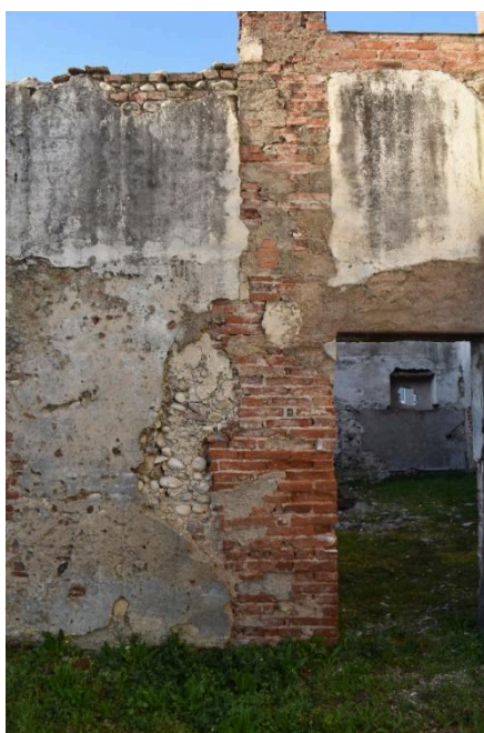
Figura 47. a) Pilastro sud-ovest della tettoia sud in appoggio alla parete ovest della casa; b) pilastro annegato nella parete sud a sostegno della teza (si nota la costruzione della parte bassa in rottura alla muratura).
