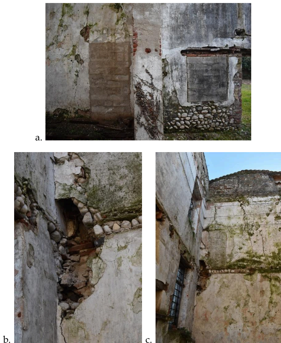
Figura 52. Controparete sud della torre colombaia: a) porta tamponata al piano terra; b) breccia d'angolo con la parete est dove si osserva l'intonaco risvoltare; c) porta o nicchia tamponata al primo piano.
