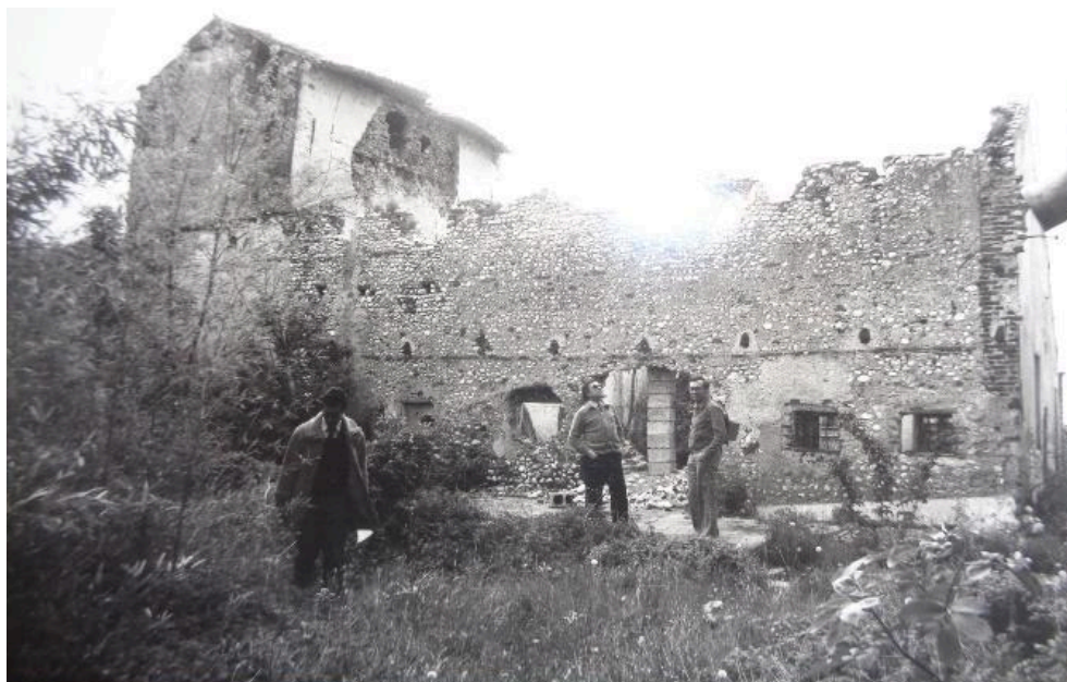
Figura 24. Vista del lato nord del rustico e della torre colombara est; Foto scattate dal Geom. R. Tescari nel 1978. (Archivio Patrimonio SABAP-Vr).
