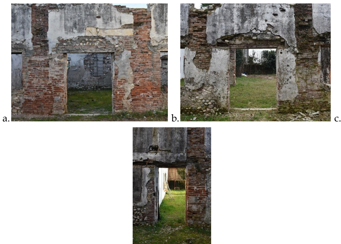
Figura 51. Portale di accesso alla casa sulla parete sud: a) vista dall'esterno, con l'architrave in pietra precedente all'attuale ligneo; b) vista dall'interno. c) Altra porta sulla parete sud vista dall'interno (la spalletta est è quella a sinistra).
