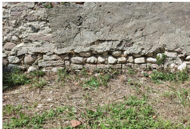
Figura 40. Tracce di apertura sul lato interno del perimetrale nord: a) spalletta est inglobata nella ricostruzione muraria; b) soglia in cotto e parte della spalletta ovest.
