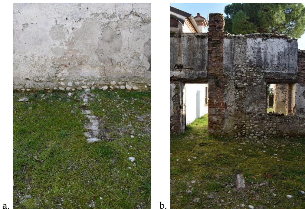
Figura 55. a) Filare in cotto in adiacenza al perimetrale ovest; b) elemento lapideo in linea con il muro divisorio interno del rudere.
