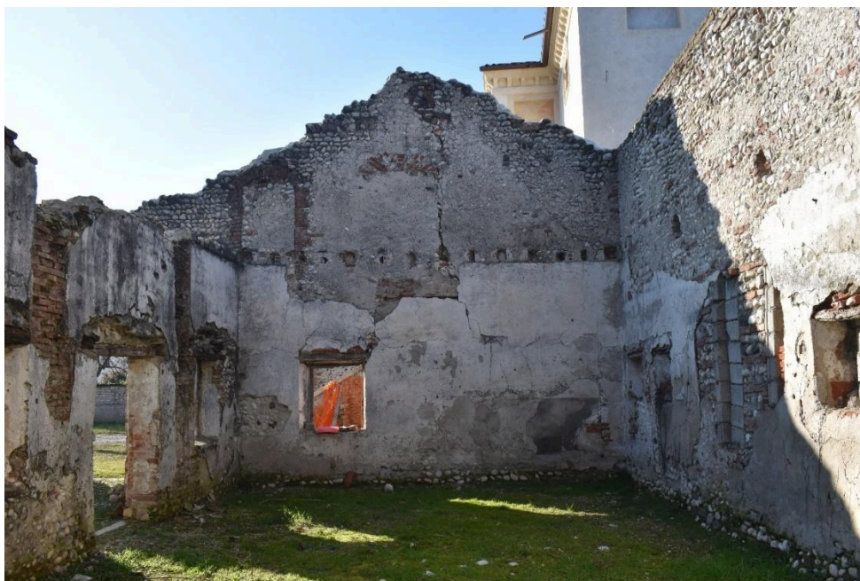
Figura 48. Tracce del solaio più recente nelle controfacciate nord e ovest; si individua la stanza del piano terra intonacata in bianco, mentre al piano superiore (teza), le pareti sono nude.
