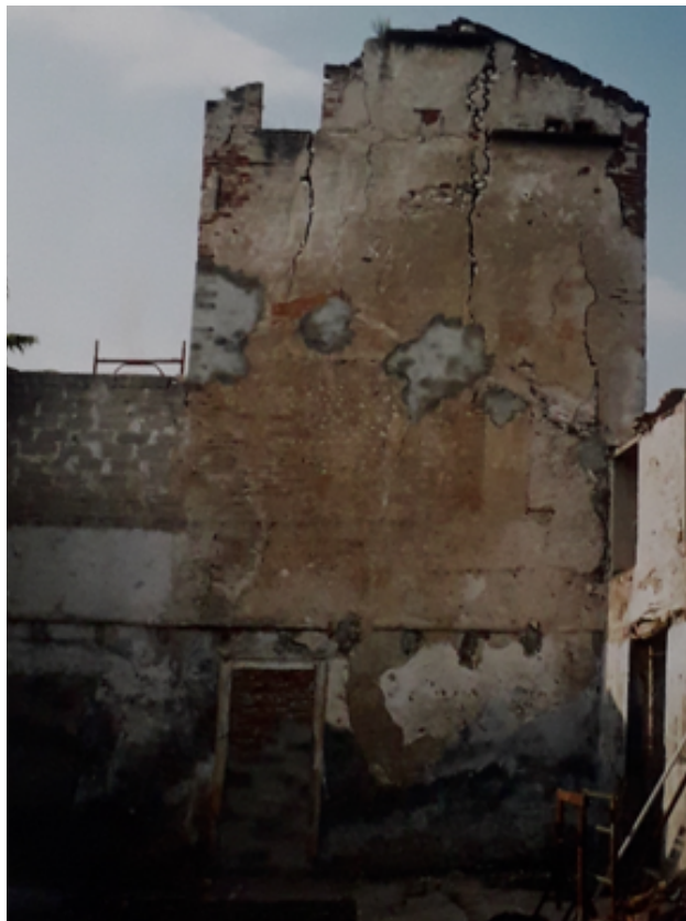
Figura 28. Foto del 2001 che mostra il prospetto sud della torre; vista dalla proprietà adiacente durante dei lavori. (Archivio Patrimonio SABAP-Vr)
