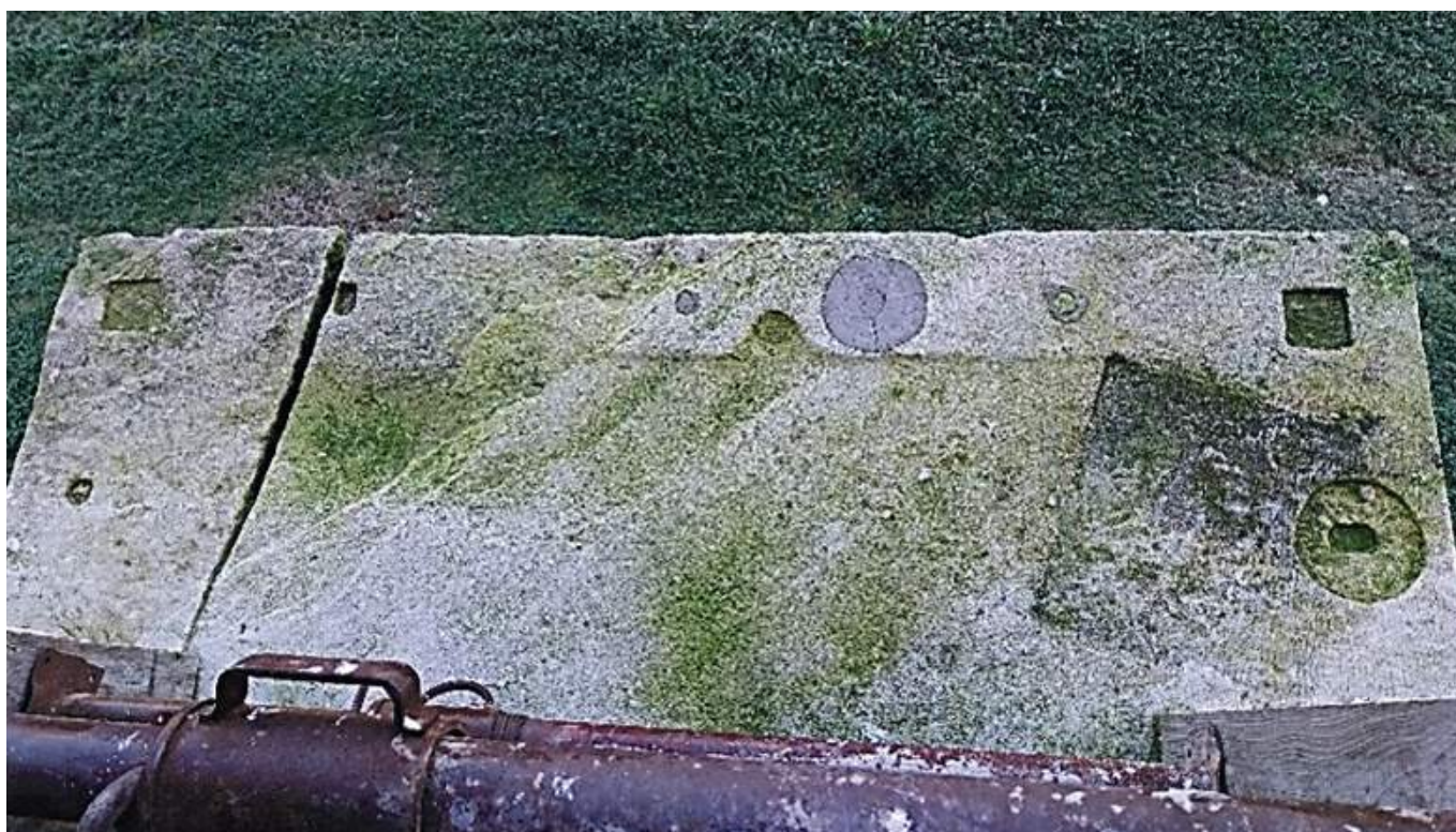
Il terrazzo sul lato nord costruito nel 1902
