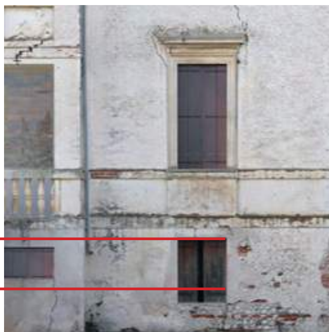
Dettaglio della finestra del piano terra nello stato di fatto (4)
