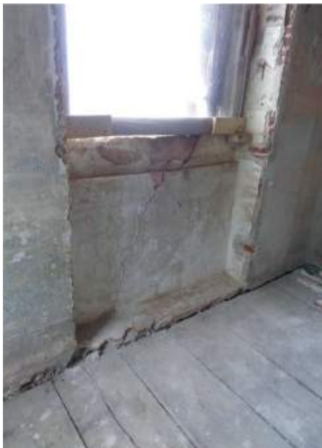
Le nicchie sottofinestra ripristinate (1)
