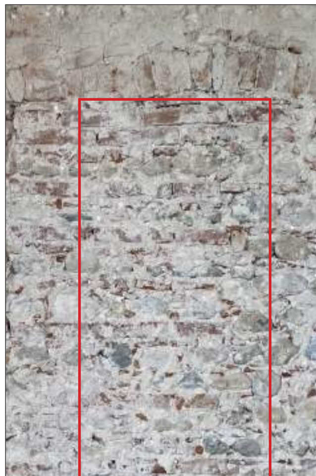
La porta tamponata della parete 2 a nord
