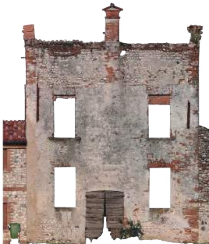
Prospetto est del rudere
