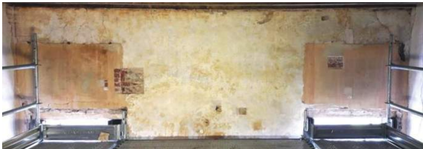
Dettaglio delle due nicchie murate all'interno in corrispondenza del salone al piano nobile
