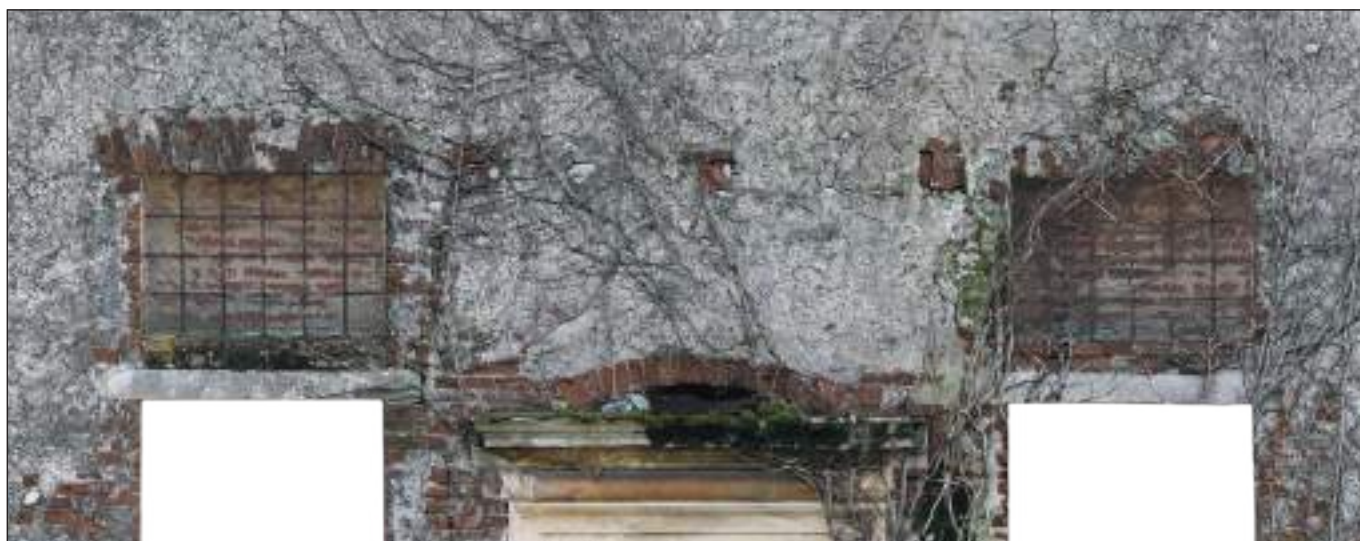
Dettaglio delle due nicchie murate con inferriate all'esterno
