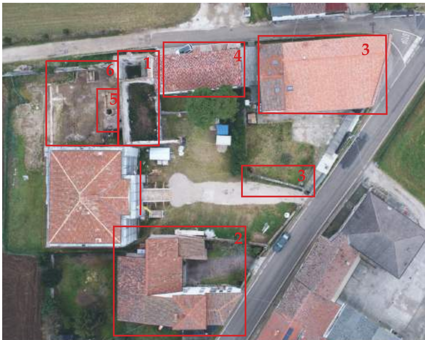
Foto aerea del sito nel 2022, durante i lavori di restauro
