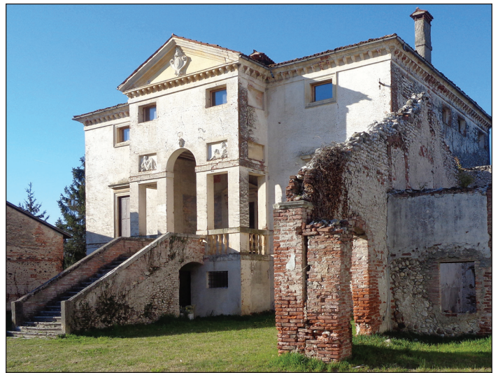
Villa Forni Cerato
