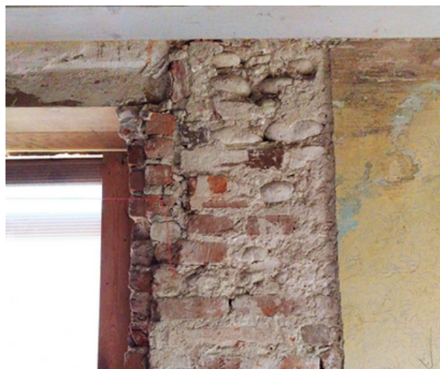
Figura 13. Tavella nella tessitura in mattoni: a sinistra spalletta e a destra imbottite della porzione ovest della finestra 1.
