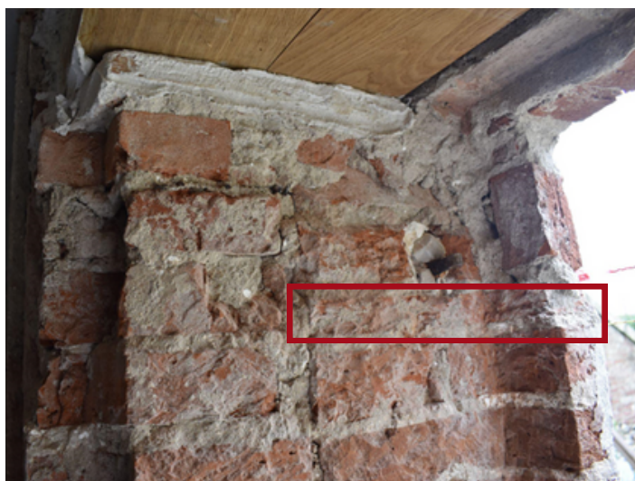
Figura 10. Tavella nella tessitura in mattoni: a) imbotte e b) spalletta sul lato interno della porzione est della finestra 1
