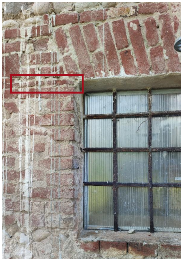
Figura 9. Tavella che delimita il filo superiore del foro esterno delle finestre 12 e 14
