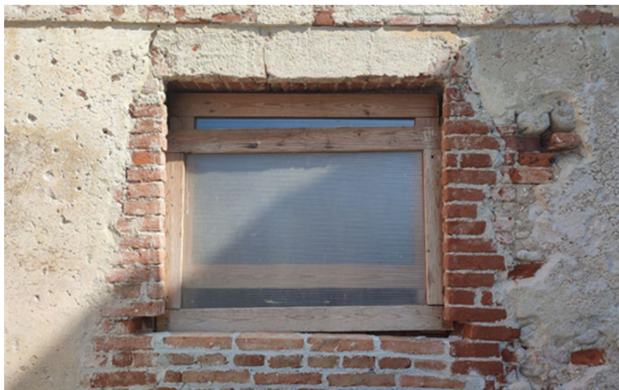
Figura 14. Finestra 5: a sinistra vista esterna, con parziale ricostruzione del davanzale dopo l'ampliamento verso il basso ad opera della famiglia Grendene; a destra vista interna.
