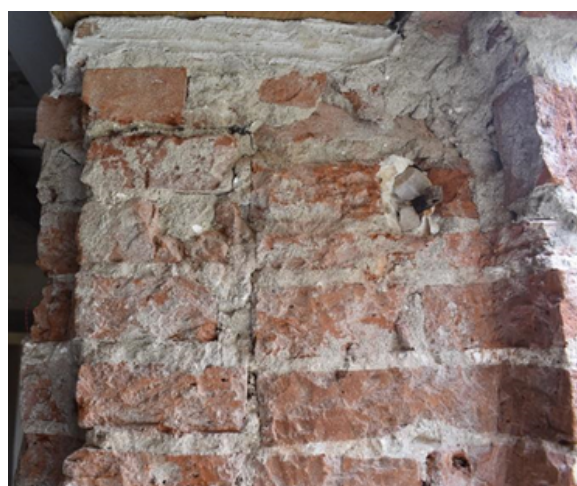
Figura 6. Dettagli dell'estremità superiore dell'imbotte nella 1. A sinistra la battuta dello scuro verso l'esterno, cardine e tavella al di sotto, alloggio per il serramento e discontinuità costruttiva verso l'interno dell'edificio; a destra mattone inclinato all'estremità superiore dell'imbotte.
