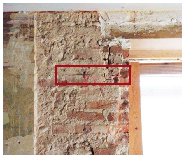
Figura 10. Tavella nella tessitura in mattoni: a) imbotte e b) spalletta sul lato interno della porzione est della finestra 1
