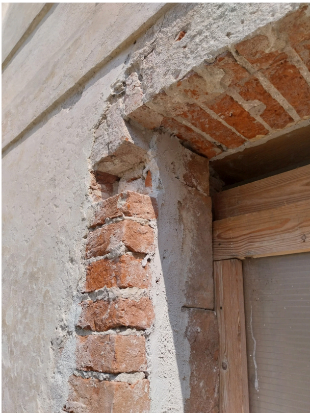
Figura 15. Dettagli della finestra 5: a sinistra l'imposta dell'architrave sulla spalletta ovest; a destra il margine di rottura tra la spalletta est e la muratura preesistente, dove si evidenzia la presenza di una tavella.
