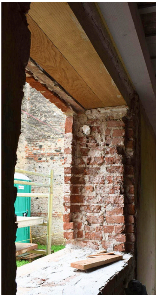
Figura 11. Finestra 1, spalletta ovest: a sinistra estremità superiore dell'imbotte, dove si notano le discontinuità costruttive e la presenza dei mattoni sagomati nello spigolo al di sotto dell'architrave; a destra estremità inferiore con la ricostruzione con mattoni sagomati delle parti angolari.
