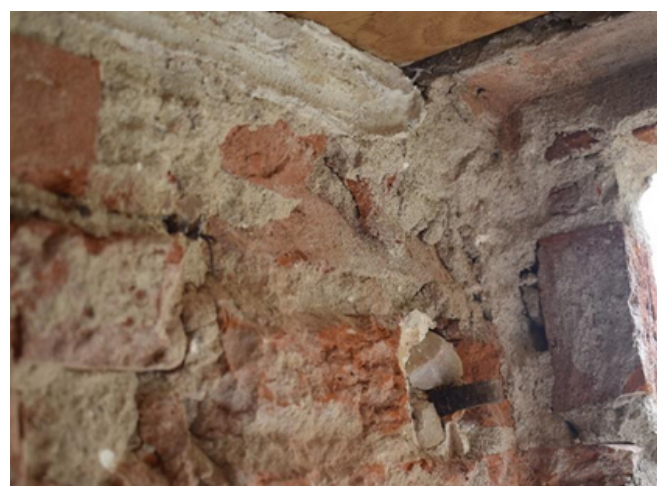
Figura 6. Dettagli dell'estremità superiore dell'imbotte nella 1. A sinistra la battuta dello scuro verso l'esterno, cardine e tavella al di sotto, alloggio per il serramento e discontinuità costruttiva verso l'interno dell'edificio; a destra mattone inclinato all'estremità superiore dell'imbotte.
