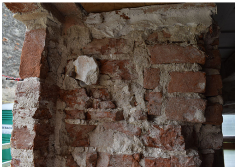
Figura 13. Tavella nella tessitura in mattoni: a sinistra spalletta e a destra imbottite della porzione ovest della finestra 1.
