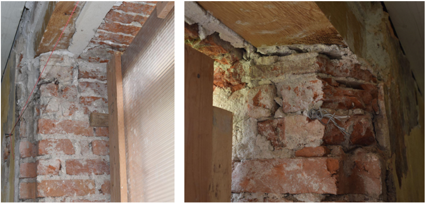
Figura 16. Dettagli delle imbotti della finestra: ricostruzione dell'imposta dell'architrave a sinistra sulla spalletta est; a destra sulla spalletta ovest.
