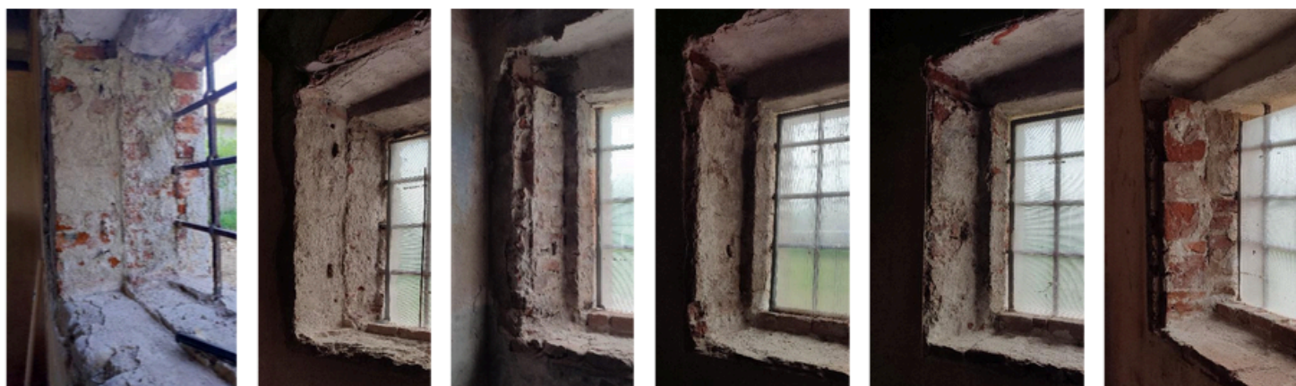
Figura 5: Alcuni esempi di spallette delle finestre del piano terra; si nota che le dimensioni del foro esterno sono ridotte rispetto a quello interno.
