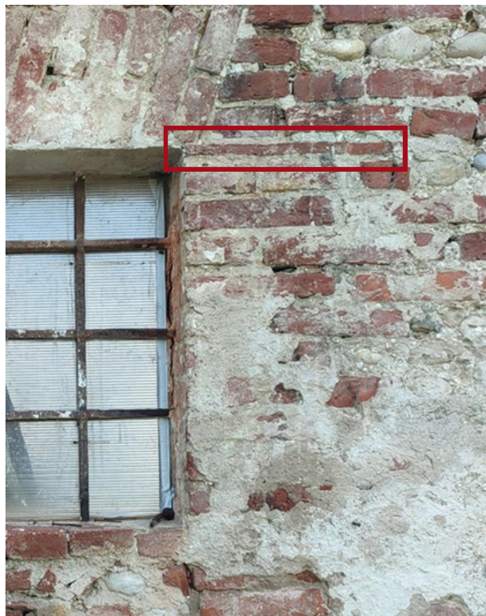
Figura 9. Tavella che delimita il filo superiore del foro esterno delle finestre 12 e 14
