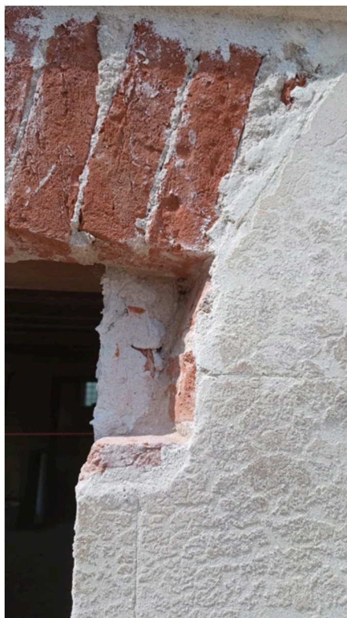
Figura 8. A sinistra rimozione dei pezzi di mattone di imposta della piattabanda della finestra 1; a destra dettagli in corrispondenza della spalletta est.
