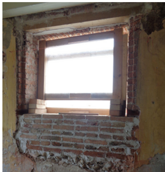
Figura 14. Finestra 5: a sinistra vista esterna, con parziale ricostruzione del davanzale dopo l'ampliamento verso il basso ad opera della famiglia Grendene; a destra vista interna.
