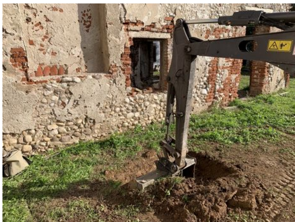
Fig. 70: Trincea T04 – in fase di scavo
