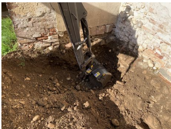
Fig. 66: Saggio SF1 – in fase di scavo
