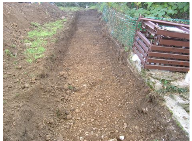
Fig. 21: Trincea T05: completamente scavo, presa da W.
