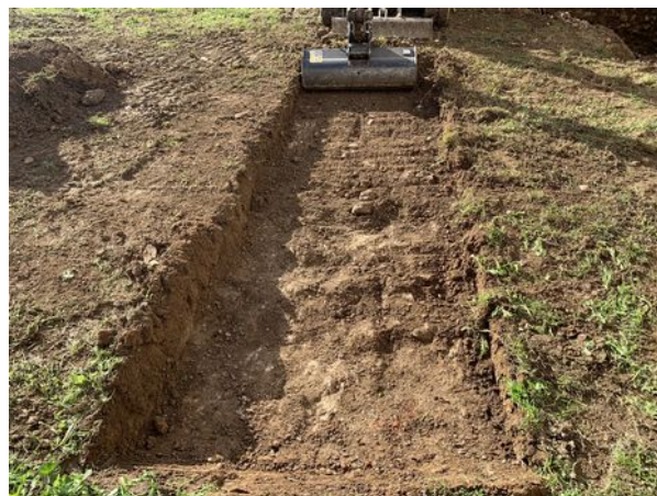
Fig. 71: Trincea T04 – in fase di scavo (US 342)
