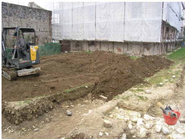
Fig. 45: Trincea T08: parziale riempimento.
