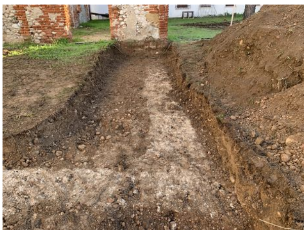
Fig. 76: Trincea T01 – in fase di scavo (US 326)
