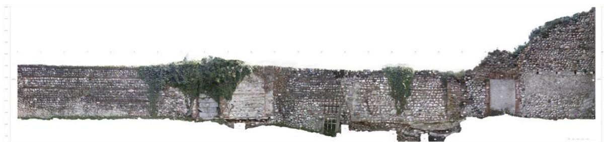
Fig. 105: Ortofoto del prospetto ovest del muro di recinzione orientale: lettura della stratigrafia muraria
