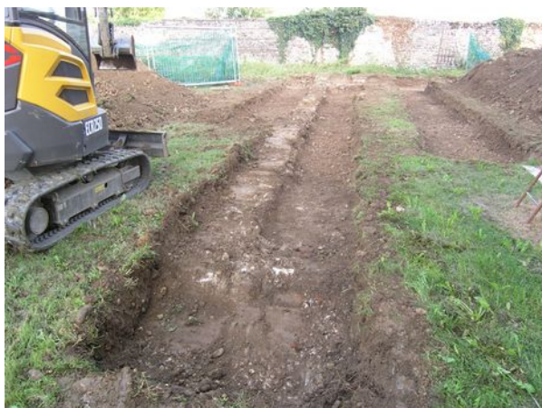
Fig. 26: Trincea T07: fase di scavo; presa da W.
