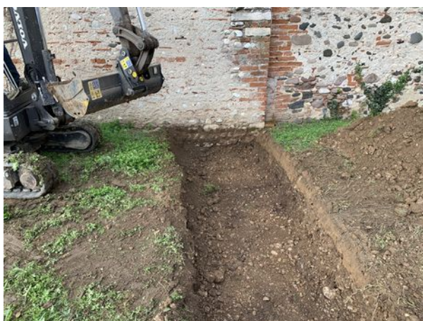
Fig. 78: Trincea T01 – in fase di scavo (estremità W)
