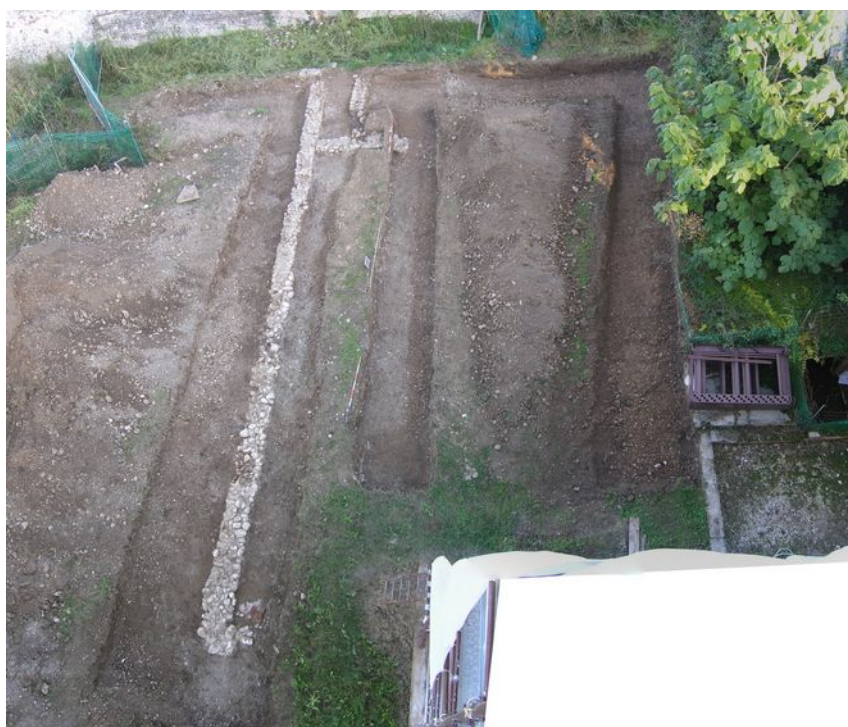
Fig. 36: Panoramica dell'area di scavo presa dall'alto.
