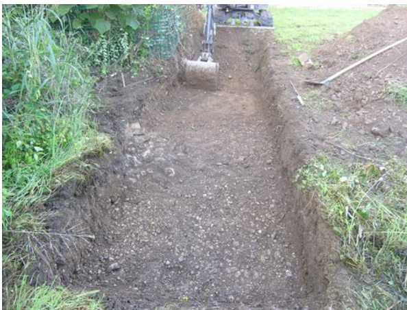
Fig. 20: Trincea T05: fase di scavo, USS 130, 132; presa da E.
