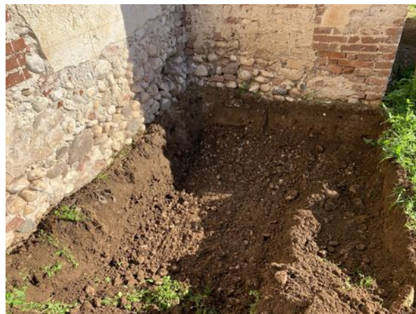
Fig. 69: Sondaggio T03B – a scavo completato
