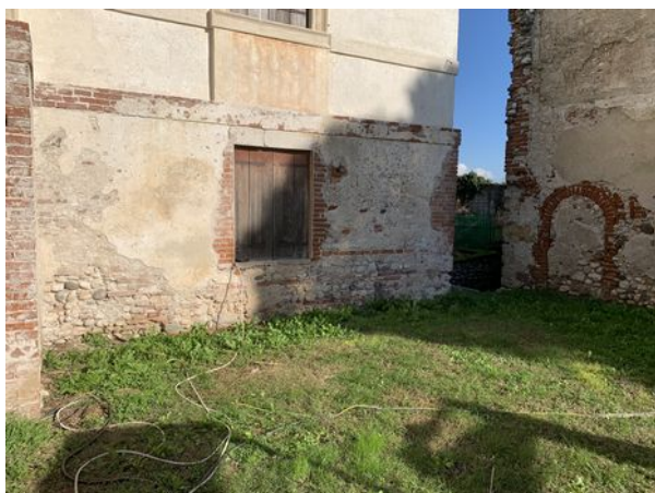
Fig. 64: Trincea T03 – prima dello scavo
