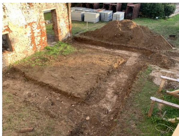
Fig. 77: Trincee T04, T02, T01 – in fase di scavo: USS 326, 333
