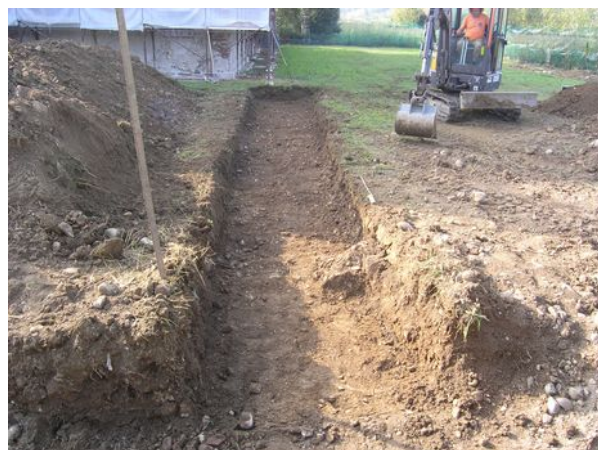
Fig. 25: Trincea T08: completamente scavo: US 109; da E.
