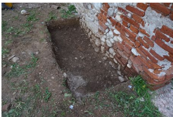
Fig. 98: Sg05: sondaggio di verifica.
