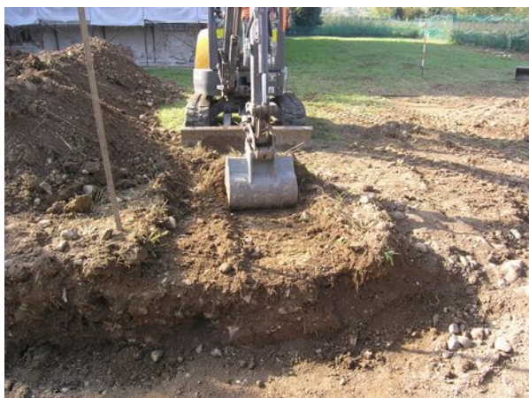
Fig. 24: Trincea T08: fase di scavo; presa da E.
