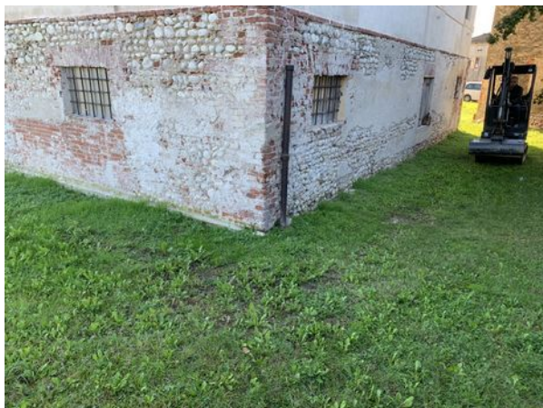
Fig. 62: Saggio FS2 – prima dello scavo
