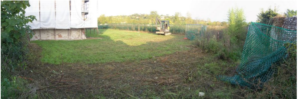
Fig. 18: Area 3. Panoramica prima dell'inizio degli scavi. Presa da SE.
