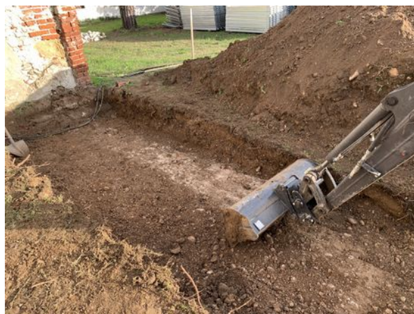
Fig. 75: Trincea T01– in fase di scavo (US 326)
