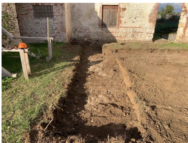
Fig. 72: Trincea T02 – in fase di scavo (US 333)
