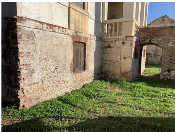
Fig. 68: Sondaggio T03B – prima dello scavo
