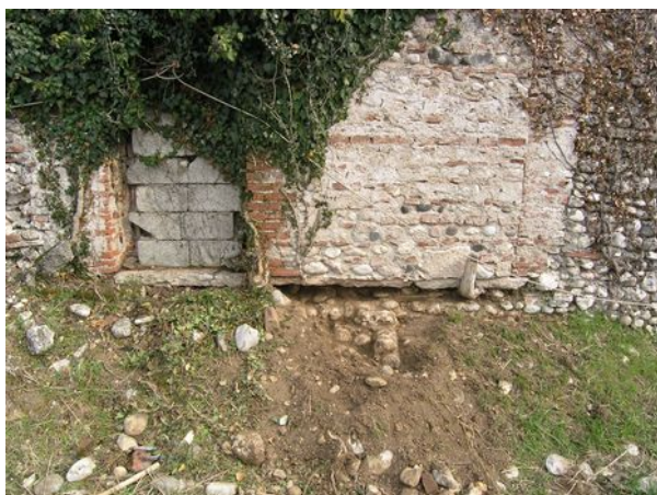
Fig. 53: Sondaggio S09: USM 319. Fase di scavo.
