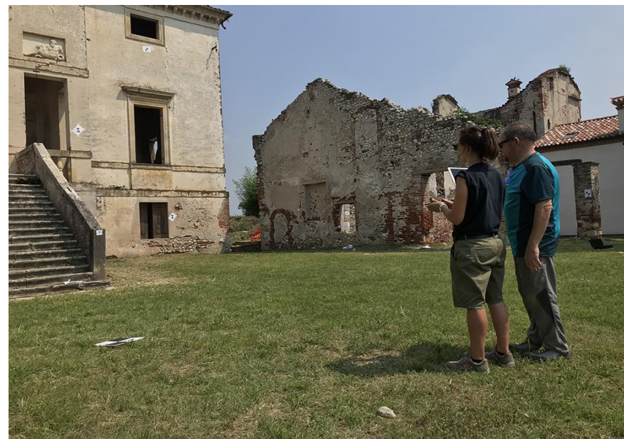
Rilievo in sito
