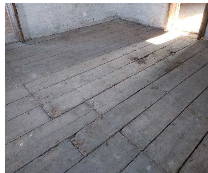
Stratigrafia rilevata al solaio del piano nobile stanza centrale e pavimentazione di recente allocazione
