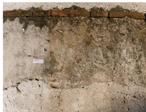
Prima e dopo la pulitura con trattamento biocida con evidenza delle estese porzioni di rifacimento di intonaco
