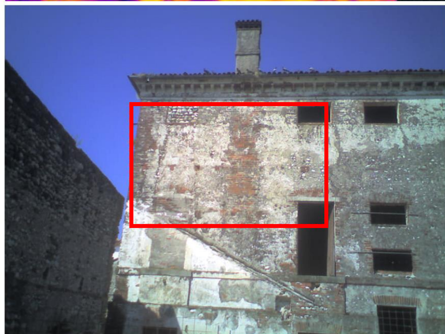
Prospetto est. Mappa termografica condizionata dalle porzioni residue di intonaco e dalla presenza di una canna fumaria
