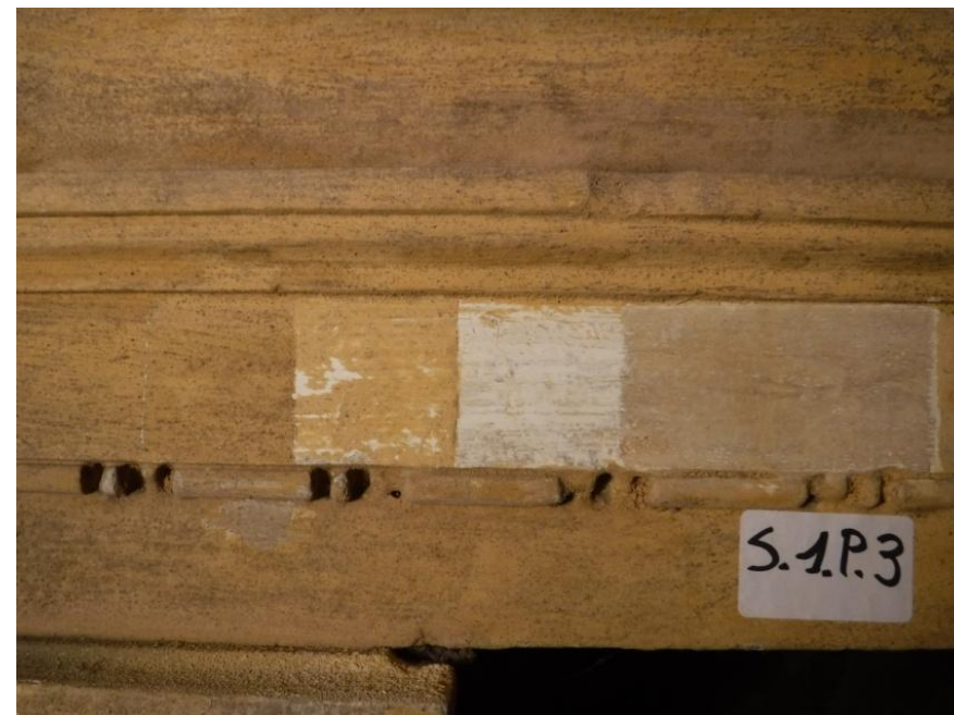
Stratigrafia cornice camino stanza 1 a sud-ovest
