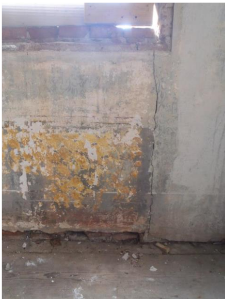
Sottofinestra stanza 3 a ovest prima e dopo la rimozione parziale della tamponatura
