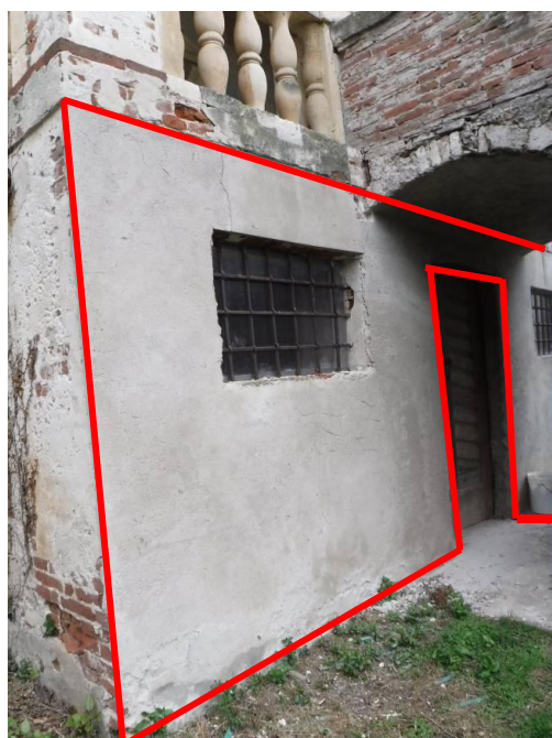
Riprese in malta cementizia
