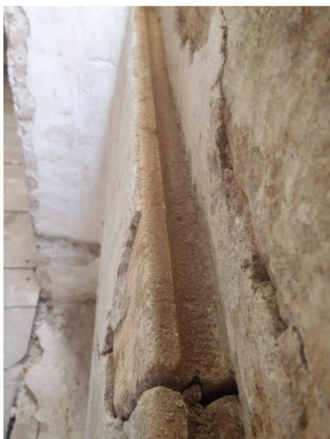
Dettaglio del gocciolatoio
