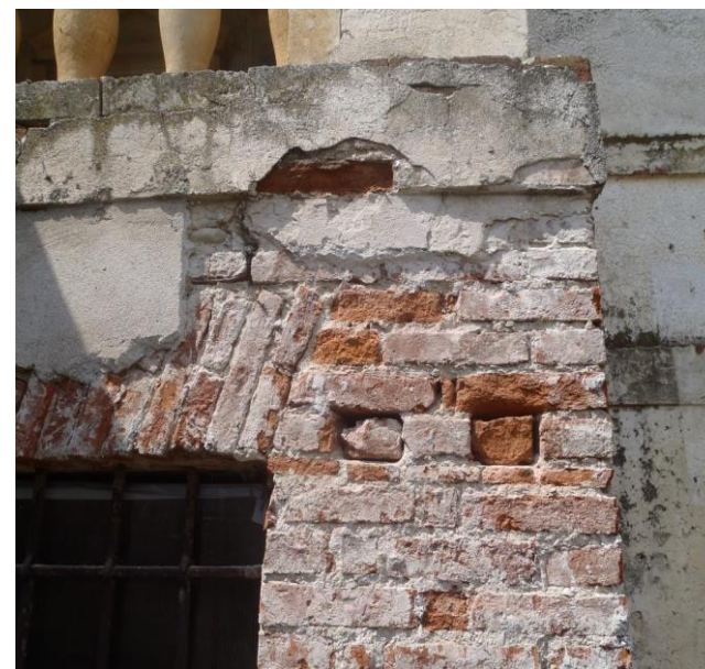
Saggi di rimozione di intonaco su pareti laterali del sotto-loggia dove sono emerse le buche pontai
