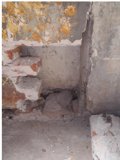
Sottofinestra stanza 3 a ovest prima e dopo la rimozione parziale della tamponatura
