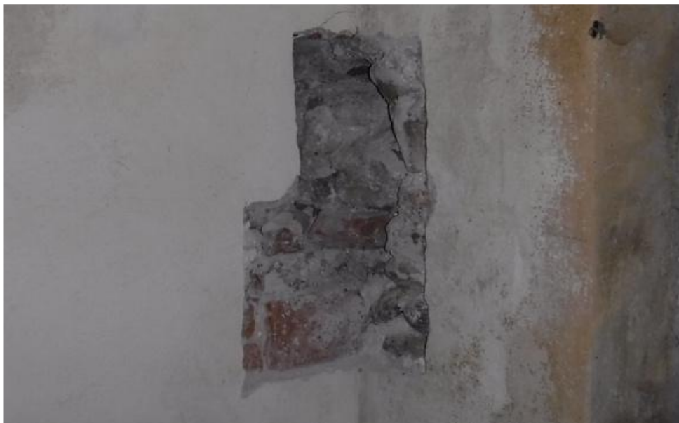
Saggio vano scale pareti nord-est
