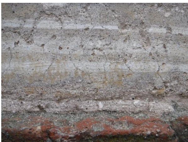
Campione di pulitura eseguito sul materiale lapideo e sull'intonaco decorato
