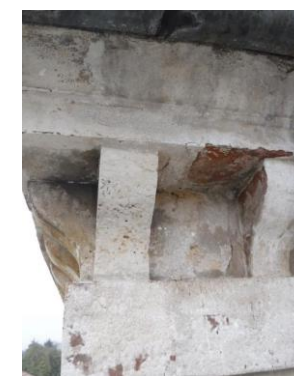
Cornice a dentelli in laterizio, eccetto elementi angolari lapidei.
