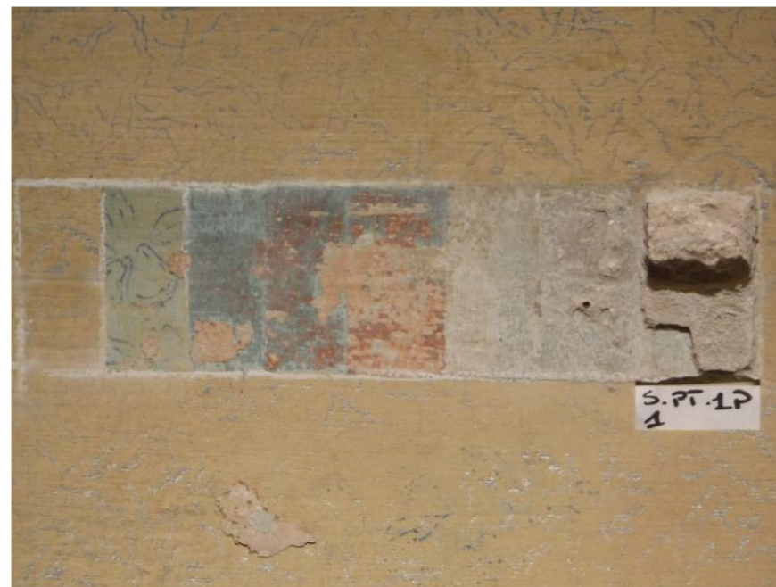
Esempio di stratigrafia – stanza 1 a sud ovest – parete ovest
