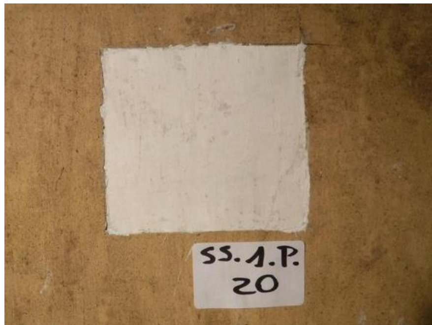
Saggi scoprimento Salone e stanza 2 a sud est con messa in luce dell'intonaco lisciato con scialbo a calce
