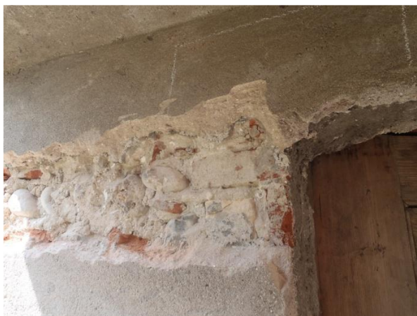
Saggi di rimozione di intonaco a sinistra e a destra della porta di accesso al piano terra sotto-loggia
