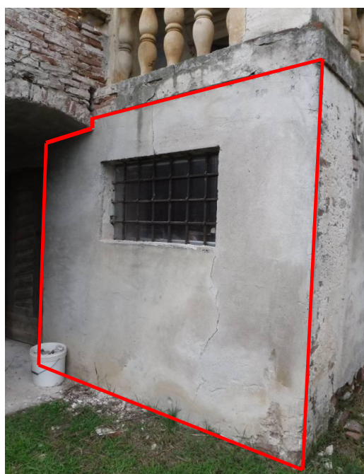
Riprese in malta cementizia
