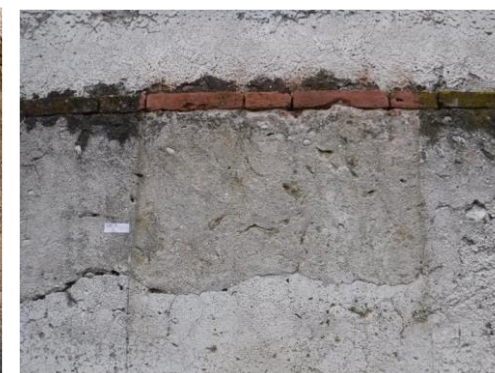
Prima e dopo la pulitura con trattamento biocida con evidenza delle estese porzioni di rifacimento di intonaco
