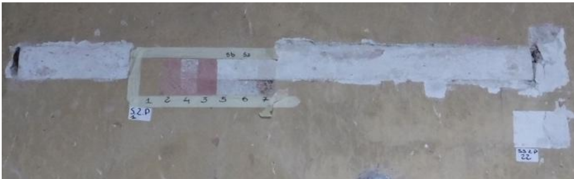
Architrave lapideo della porta che collegava la stanza a sud est con i servizi (attuale vano scale)
