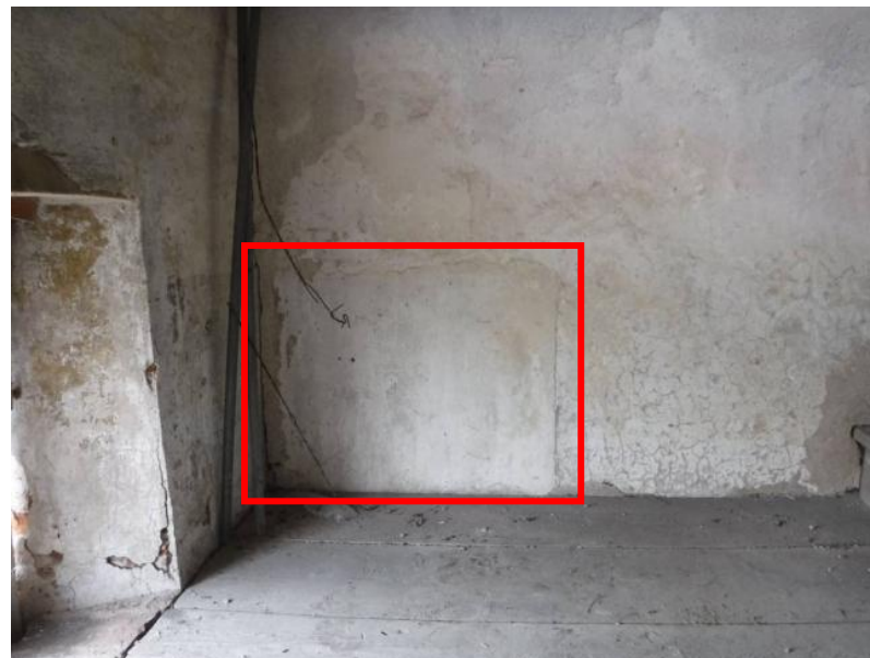
Localizzazione di ulteriori approfondimenti finalizzati alla ricerca della possibile quota pavimentale precedente
