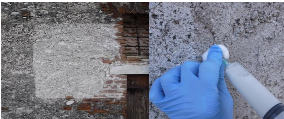
Campioni di pulitura mediante trattamento biocida e di consolidamento con PLM A
