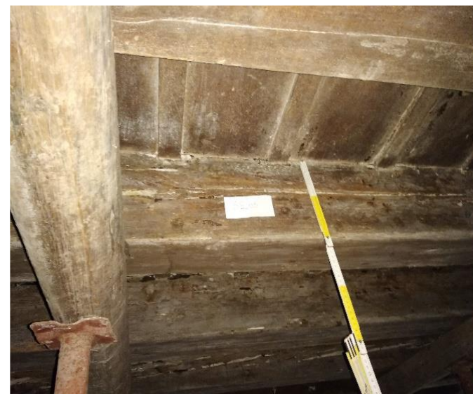
Stratigrafia al solaio del piano nobile stanza sud est
