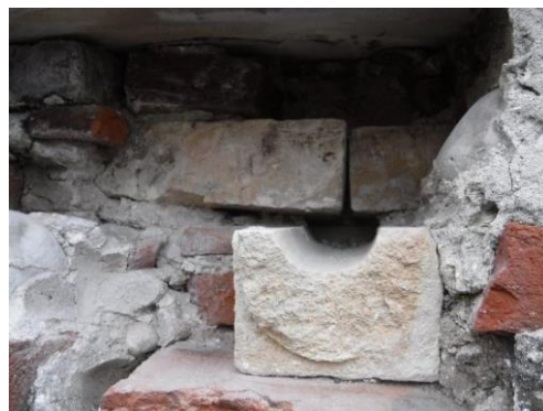
Dettaglio del gocciolatoio
