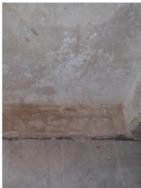
Pavimentazione in tavelle di cotto
