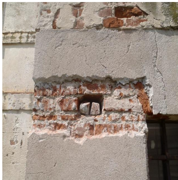
Saggi di rimozione di intonaco su pareti laterali del sotto-loggia dove sono emerse le buche pontai
