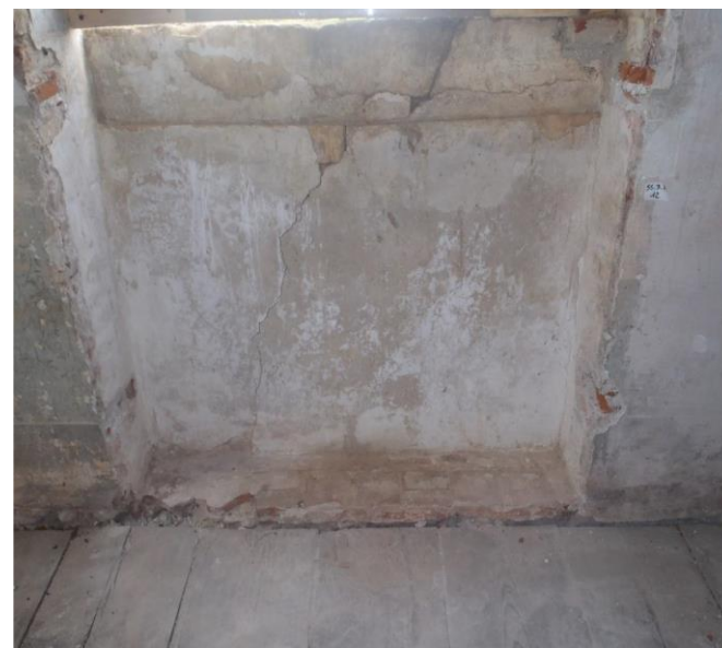
Sottofinestra stanza 3 dopo la rimozione
