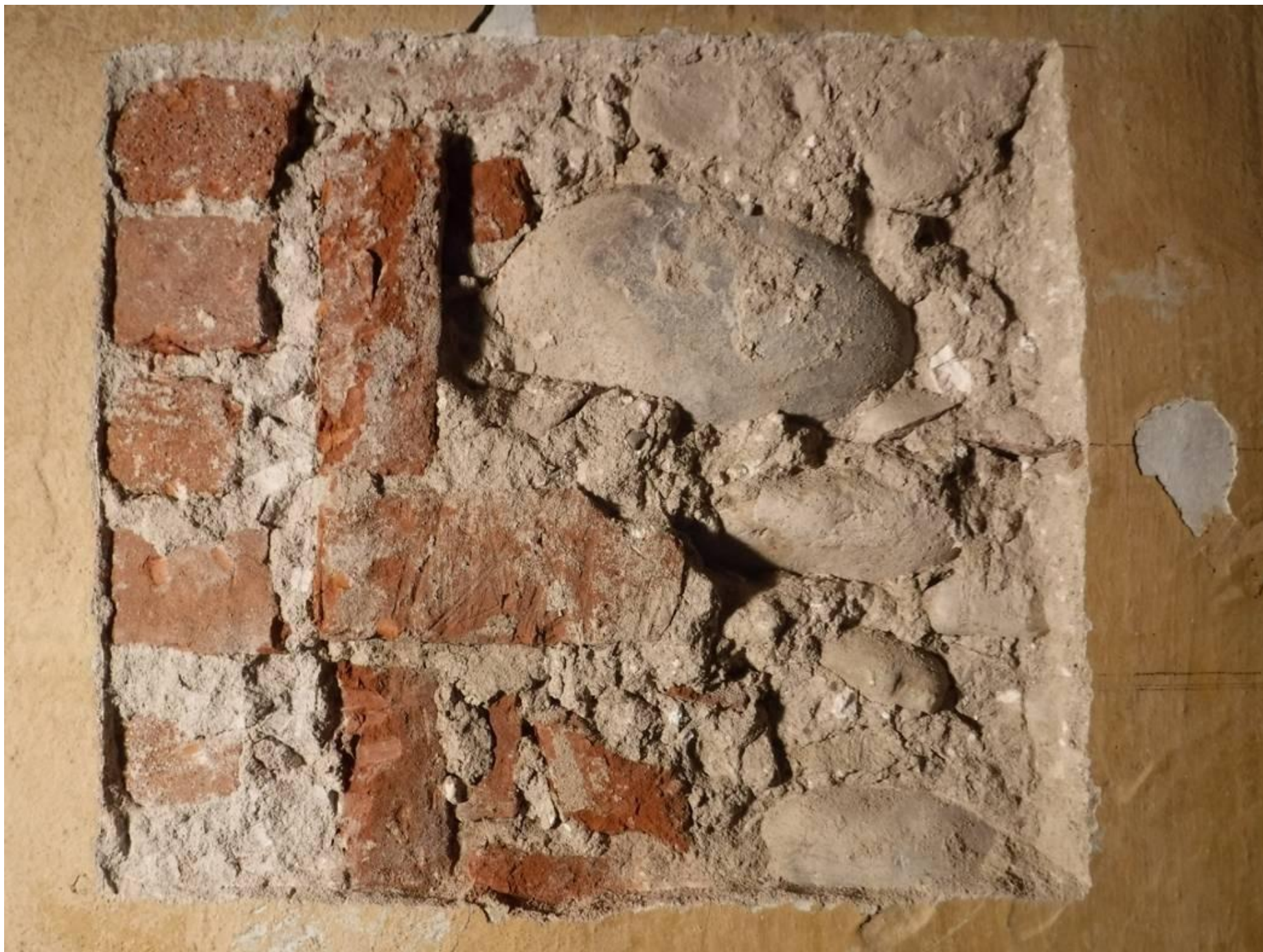
Tamponatura sopra finestra della parete nord salone
