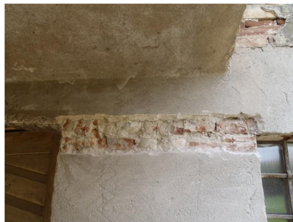
Saggi di rimozione di intonaco a sinistra e a destra della porta di accesso al piano terra sotto-loggia
