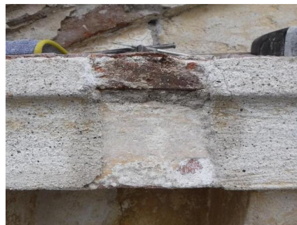
Saggi stratigrafici sulle cornici con evidenza di stesure di intonaco precedenti
