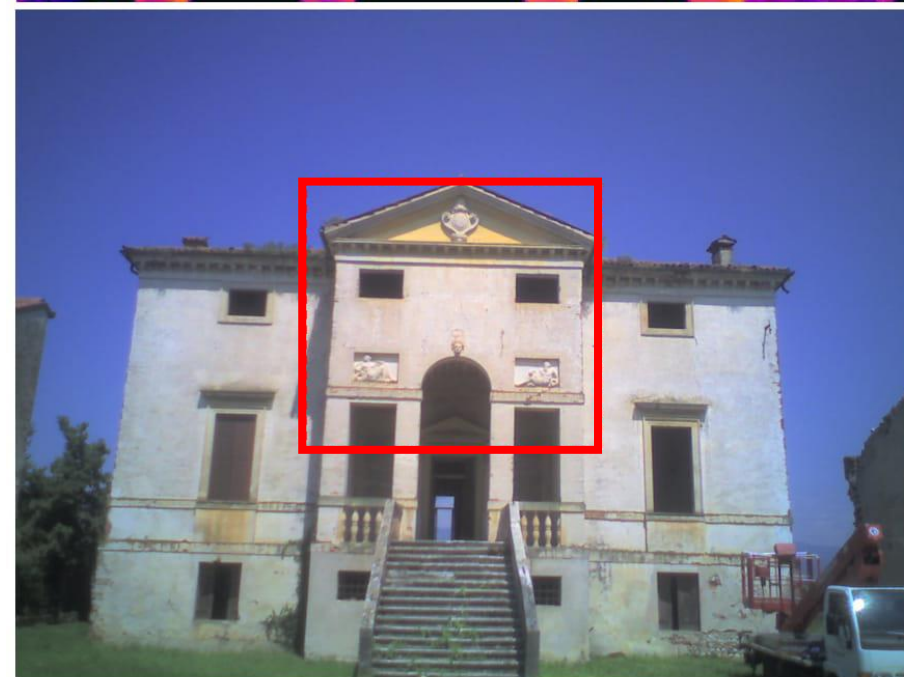
Prospetto sud. Tessitura muraria data da successione di allineamenti orizzontali di ciottoli. Spigoli e contorni delle finestre alte in laterizio.
