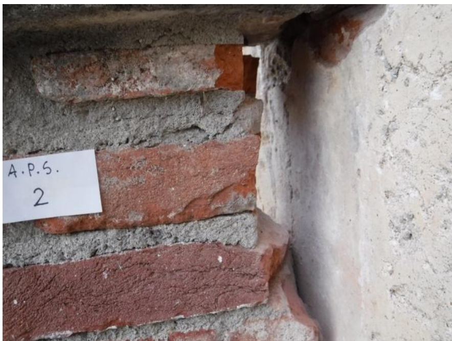
Verifica di assenza di connessione tra i muretti della balaustra della scala e i pilastri centrali della loggia
