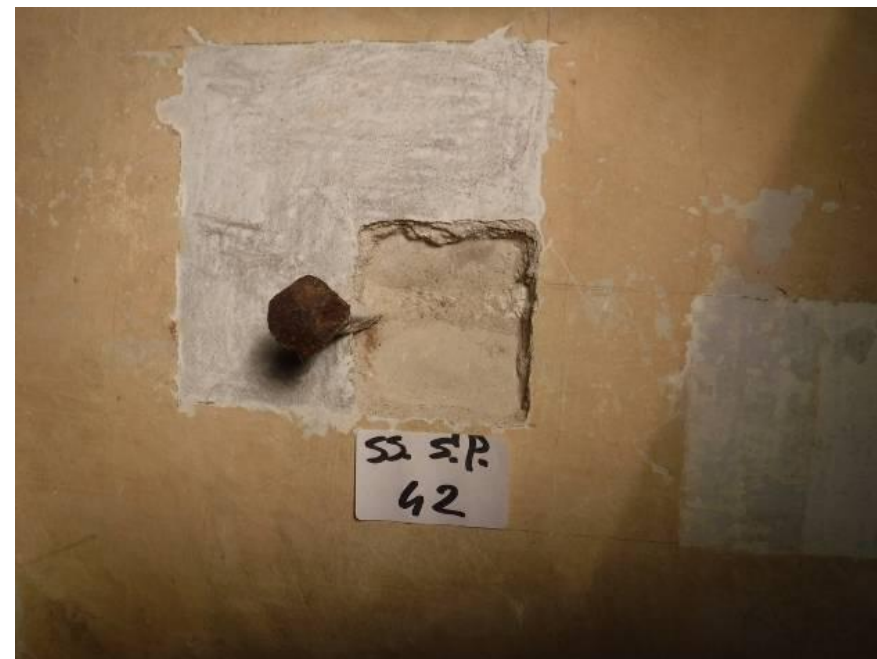
Saggi scoprimento Salone sopra porta pareti nord ed est
