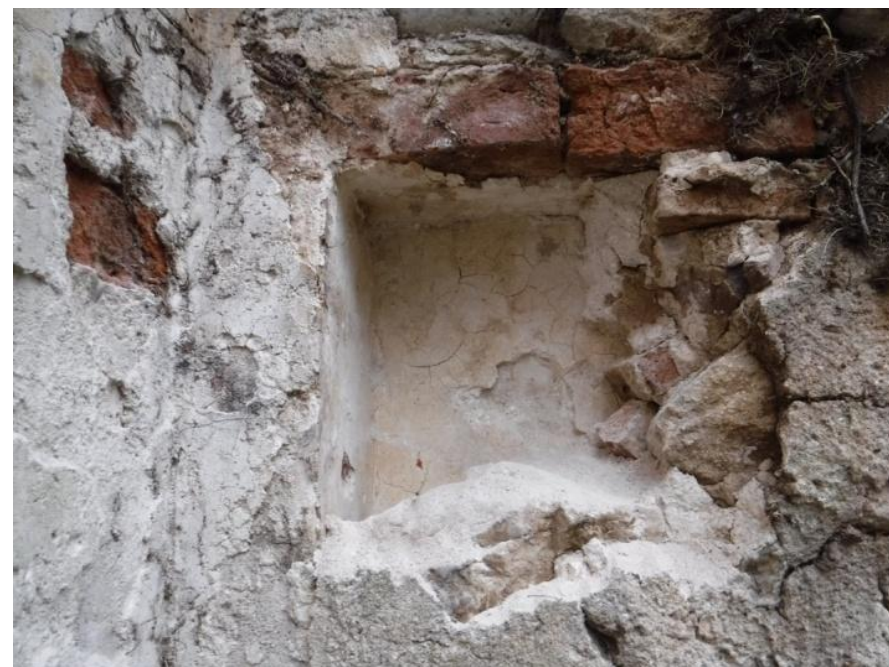
Lacerti intonaco lisciato sulle murature coperte e intonaco originario lisciato all'interno delle aperture
