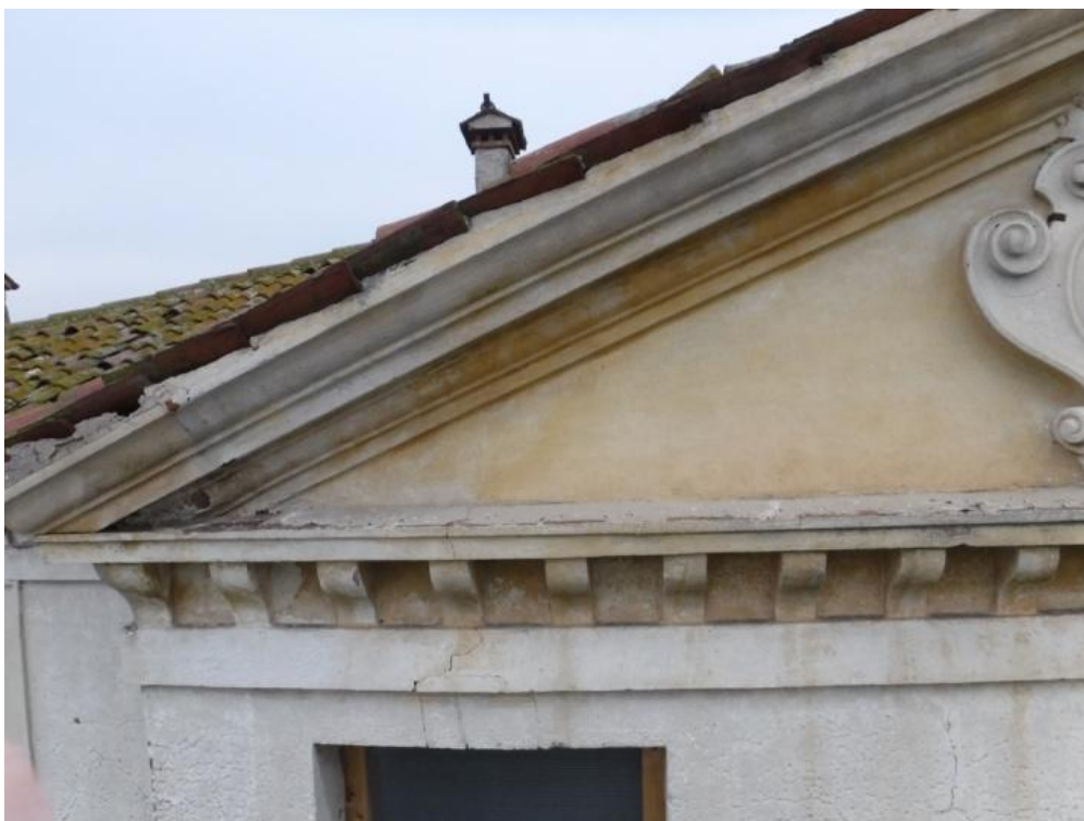
Timpano loggia – saggio sulla specchiatura centrale con evidenza della struttura muraria
