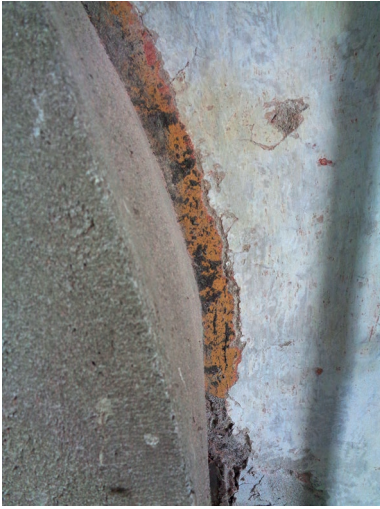
Fig. 16 Particolare del camino orientale. Il margine dell'intonaco cinquecentesco è interrotto dall'inserimento di una traccia muraria posteriore. La coloritura "spugnata" in giallo e grigio, a contatto dell'intonaco originario, è ciò che rimane della successiva ridipintura dell'intera stanza, la quale prosegue al disotto della cappa cementizia. Tale coloritura è stata a sua volta coperta da una tinteggiatura giallo ocre, ancora visibile all'interno del camino (v. fig. 17).
