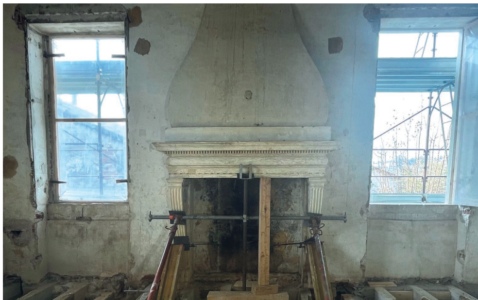
Fig. 13. Il camino monumentale della stanza a sud ovest dopo la descialbatura degli intonaci. L'intonaco cinquecentesco riveste il camino fino alla sommità della cappa, senza soluzione di continuità.
