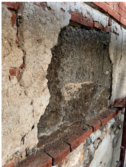
Fig. 14. Lastra di materiale refrattario rinvenuta nel camino monumentale sul lato ovest della stanza a sud ovest del piano nobile, in corrispondenza della schiena del focolare interno.
