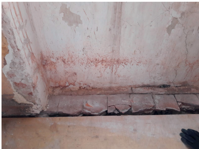
Fig. 6. Lacerto di pavimentazione in cotto emerso a seguito della demolizione della tamponatura della nicchia della sottofinestra sul lato settentrionale della stanza a nord ovest
