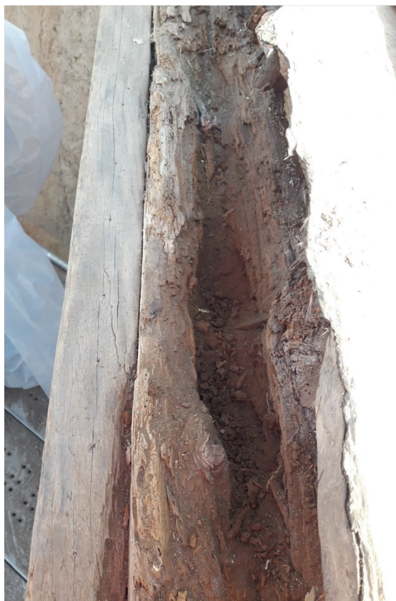
Fig. 12. Diagonale sud-ovest, stato del degrado emerso in seguito alla rimozione del manto di copertura.
