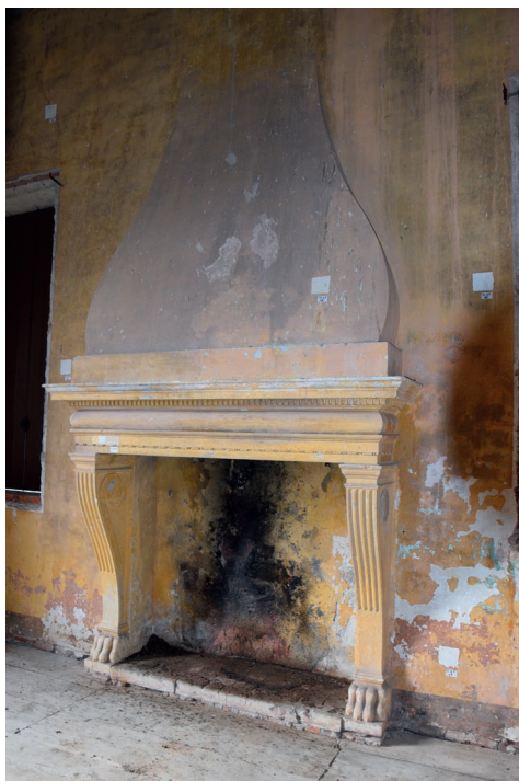
Fig. 12. Il camino monumentale della stanza a sud ovest prima della descialbatura degli intonaci.
