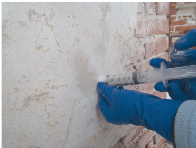
Fig. 9. Consolidamento di intonaco mediante iniezione di malta fluida PLMA a seguito di distacco dal supporto murario.
