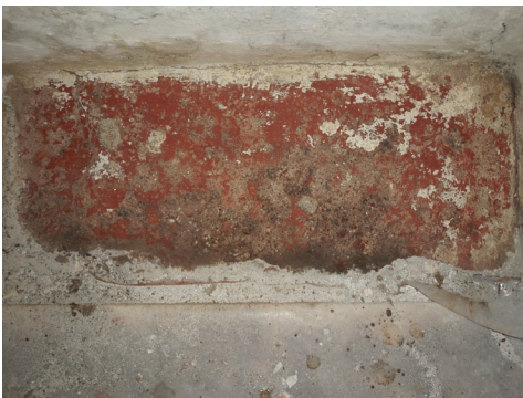
Fig. 11. Tracce di pavimentazioni emerse nelle sottofinestra a seguito della rimozione delle tamponature. Lacerti di pastellone (stanze ad est e salone centrale) e tavelle (stanze ad ovest).
