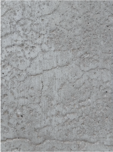
Fig. 4a-b. Esempi di fenomeni erosivi differenziali degli intonaci esterni. Gradi di severità legati all'esposizione delle facciate della villa (Fig. 4a. Prospetto sud [a sinistra] - Fig. 4b. Prospetto nord [sopra]).
