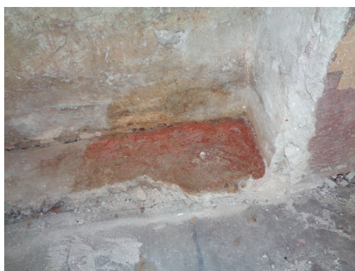
Fig. 4 (a sinistra). Particolare del doccione per lo sgrondo all'esterno delle acque piovane raccolte dalla canalina sotto il davanzale.
