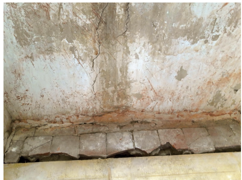
Fig. 11. Tracce di pavimentazioni emerse nelle sottofinestra a seguito della rimozione delle tamponature. Lacerti di pastellone (stanze ad est e salone centrale) e tavelle (stanze ad ovest).
