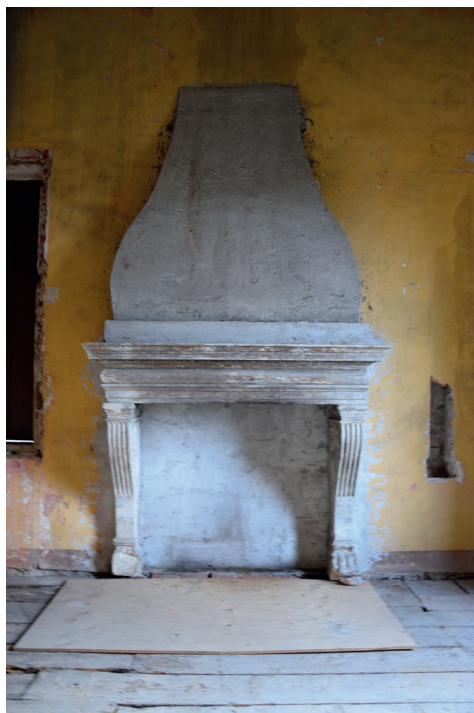
Fig. 11. Il camino monumentale della stanza a sud est prima della descialbatura degli intonaci.
