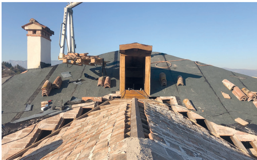
Fig. 10. Esempio di un intervento di rinforzo della trave di colmo dell'avancorpo.
