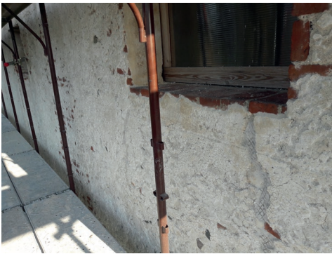
Fig. 7 (sopra). Prospetto sud: rifinitura meccanica a bisturi per la rimozione di infestazione biologica radicata.
