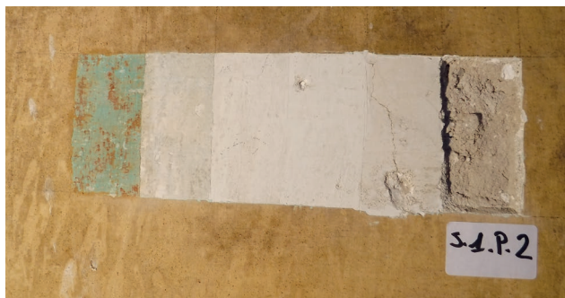
Fig. 2. Esempio di saggio stratigrafico eseguito su intonaci interni. Stanza sud-est del piano nobile.
