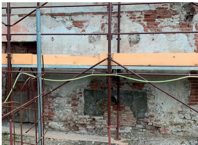
Fig. 15. Particolare dell'esterno del piano terra sul lato orientale, dove è visibile la presenza di materiale refrattario in corrispondenza della parete di fondo del probabile focolare interno.
