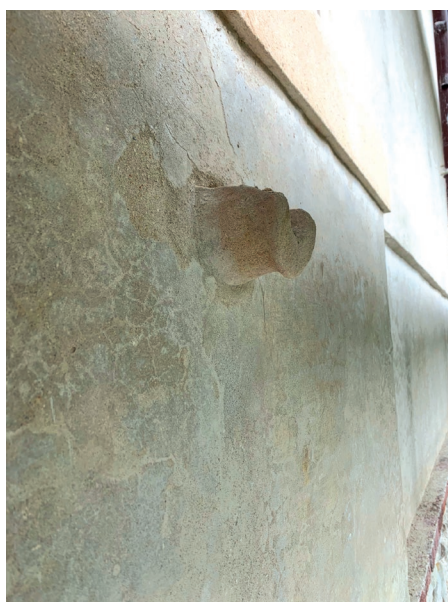
Fig. 4 (a sinistra). Particolare del doccione per lo sgrondo all'esterno delle acque piovane raccolte dalla canalina sotto il davanzale.
