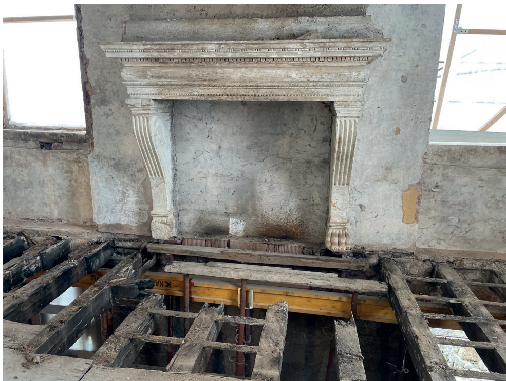
Fig. 18. Particolare del camino monumentale orientale e del suo contromuro di fondo, che, per un breve tratto, determina una bipartizione della canna fumaria.
