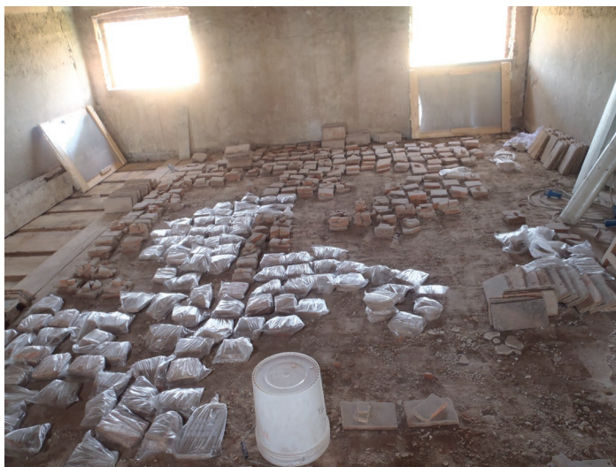
Fig. 13. Rimozione della pavimentazione in tavole del sottotetto con catalogazione e cernita degli elementi recuperabili.
