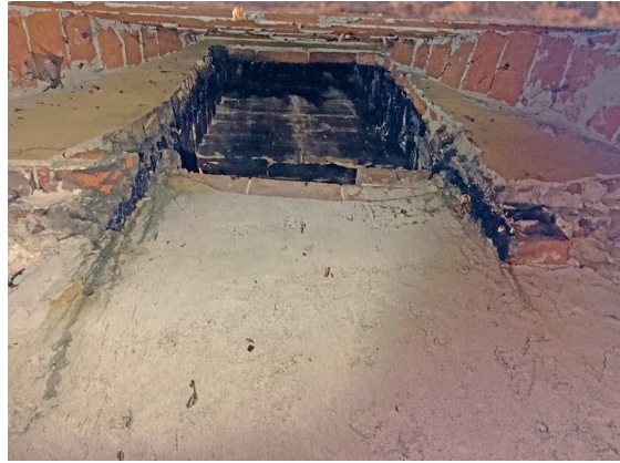
Fig. 17. Particolare dell'interno della cappa del camino monumentale orientale, il quale conserva e nasconde al suo interno l'impronta di un camino più piccolo.
