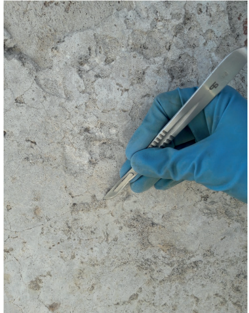
Fig. 7 (sopra). Prospetto sud: rifinitura meccanica a bisturi per la rimozione di infestazione biologica radicata.
