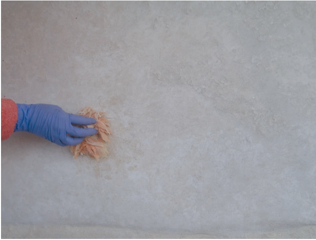
Fig. 17. Prospetto ovest: velatura finale.
